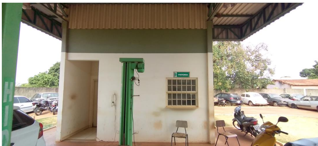
Foto 25: Área de Vistoria
