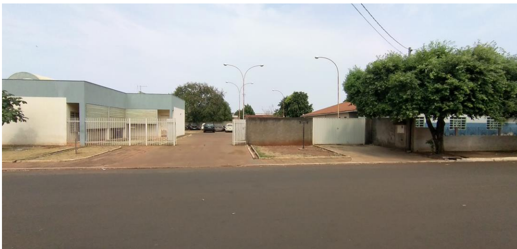
Foto 7: Calçada Externa e Portões de Acesso ao Pátio Interno
