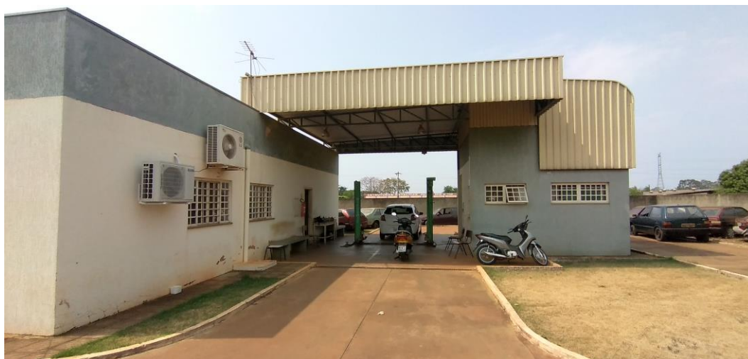
Foto 14: Área de Vistoria
