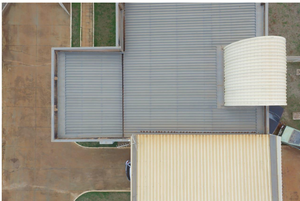
Foto 90: Telhado da Agência
