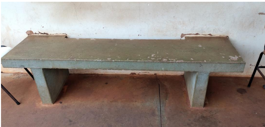
Foto 21: Banco de Concreto Danificado
