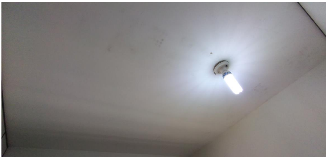
Foto 52: Laje da Sala de Digitação
