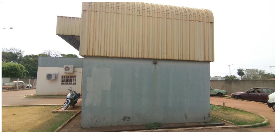
Foto 24: Fachada da Área de Vistoria
