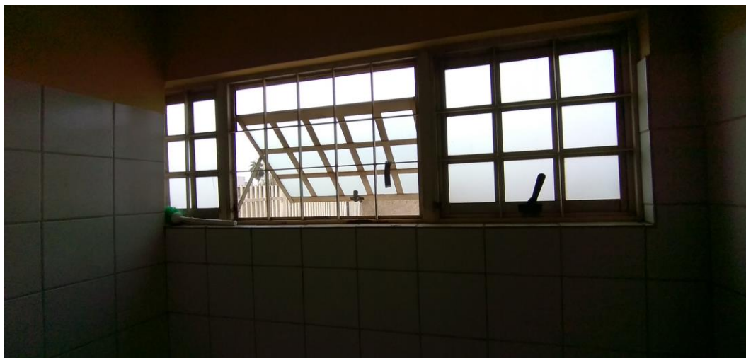
Foto 82: Janela do Banheiro Feminino
