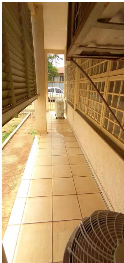
Foto 12: Janelas e Ar-Condicionado
