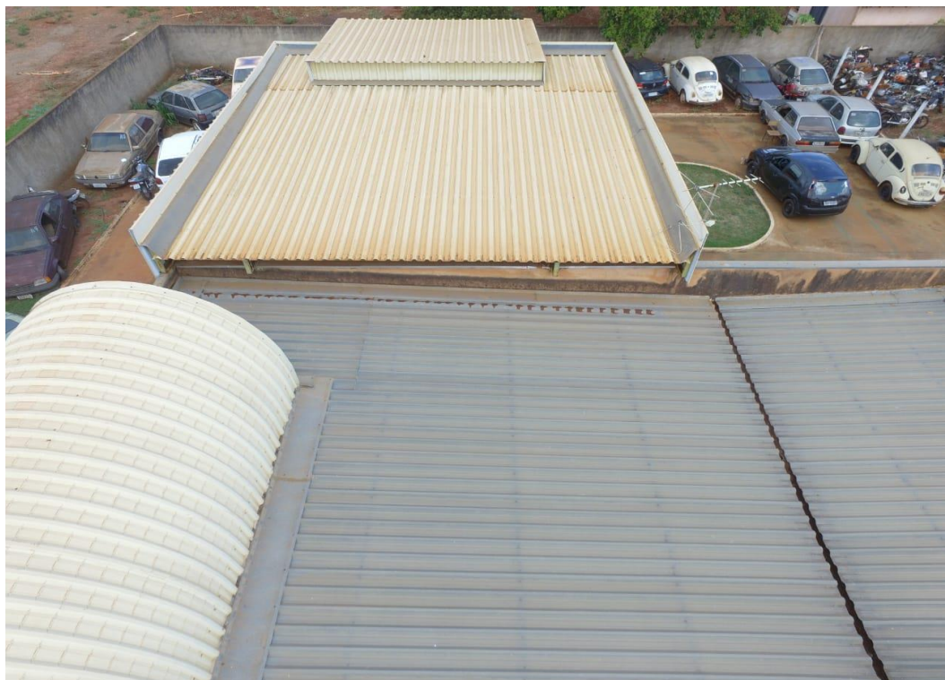
Foto 91: Telhado da Agência
