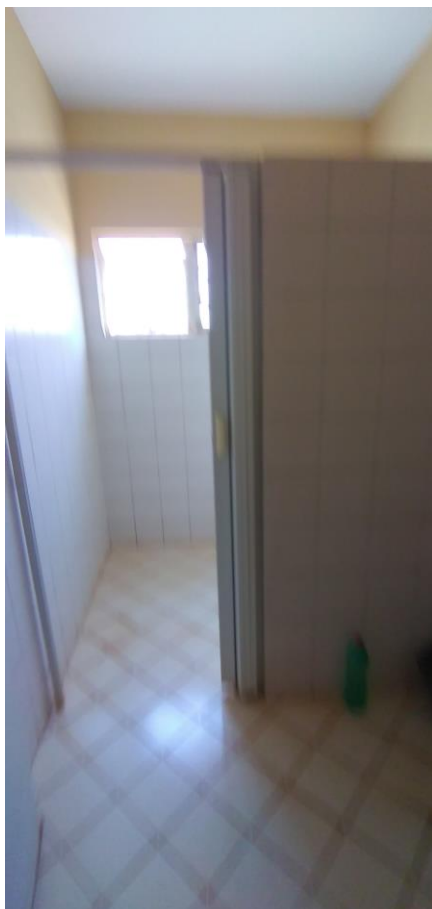
Foto 73 Acesso ao Sanitário
