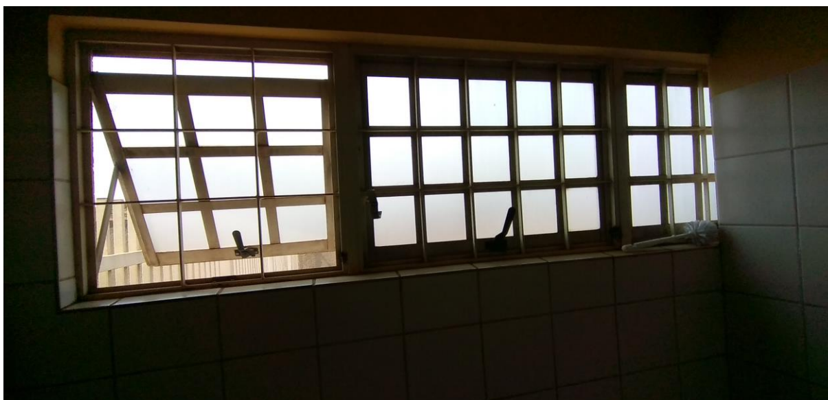
Foto 75: Janela do Banheiro Feminino
