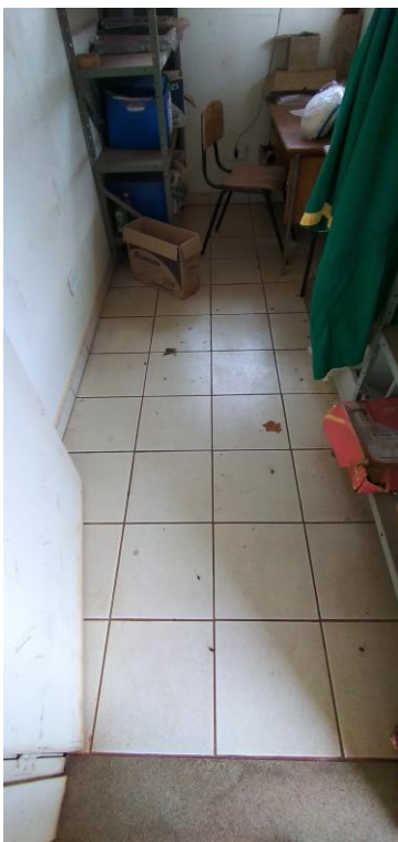
Foto 30: Piso Sala de Emplacamento
