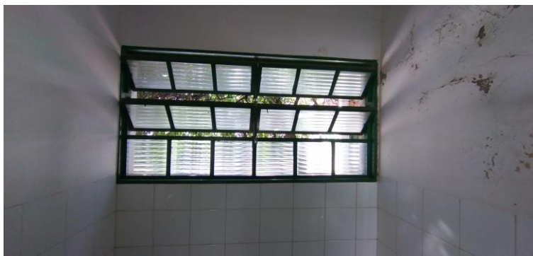
Foto 66: Janela do Banheiro Feminino
