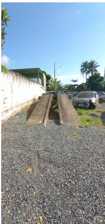
Foto 32: Rampa de Vistoria para Demolir
