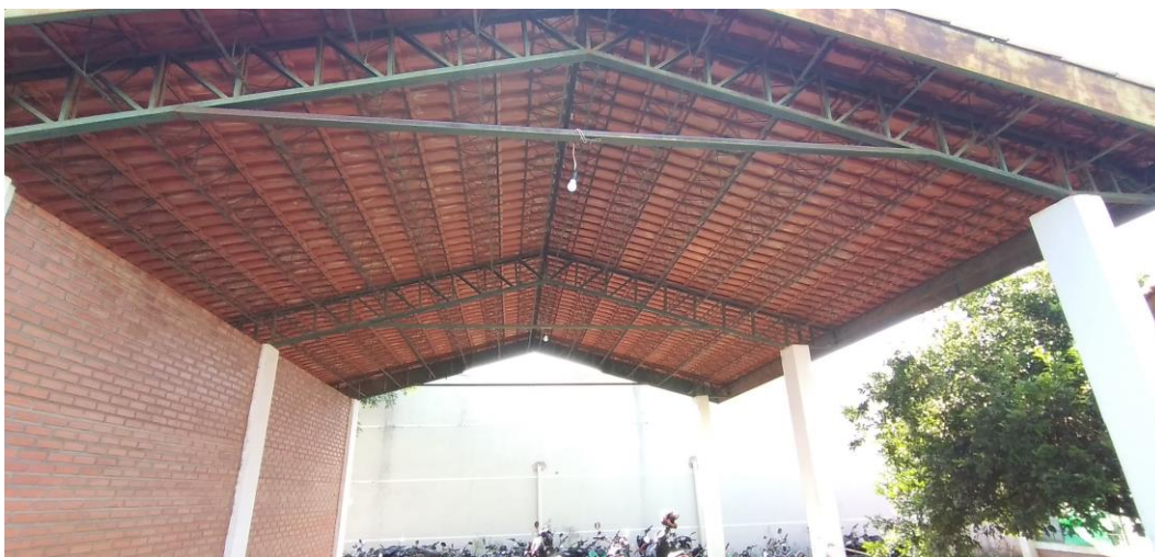
Foto 29: Telhado da Área de Vistoria
