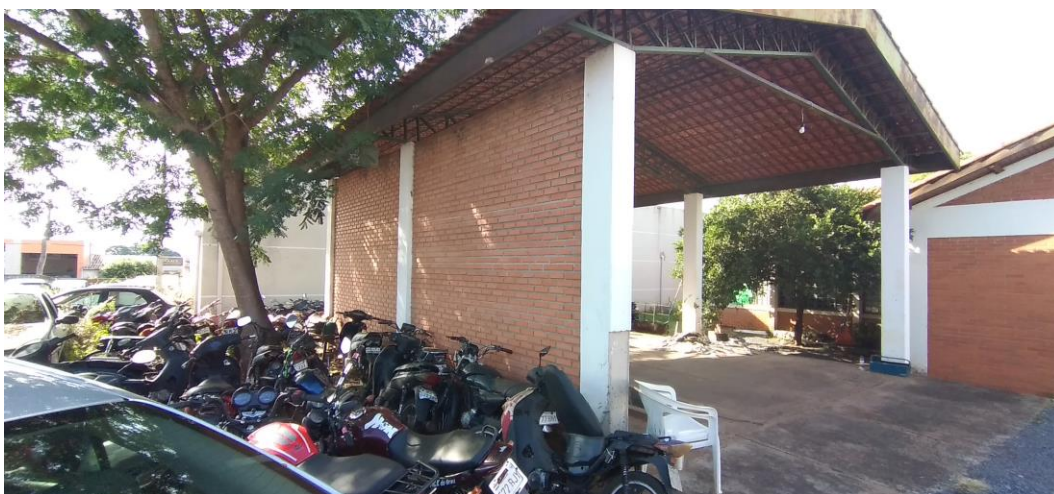
Foto 27: Área de Vistoria
