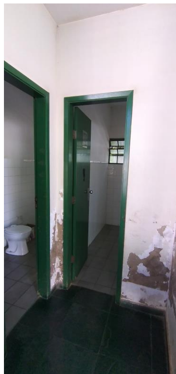
Fotos 53 e 54: Paredes da Área de Circulação Danificada
