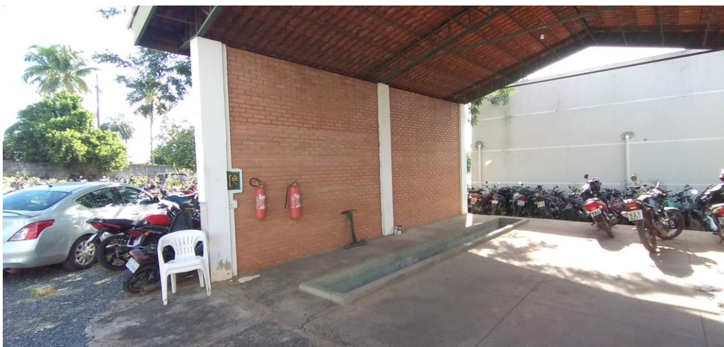
Foto 26: Área de Vistoria
