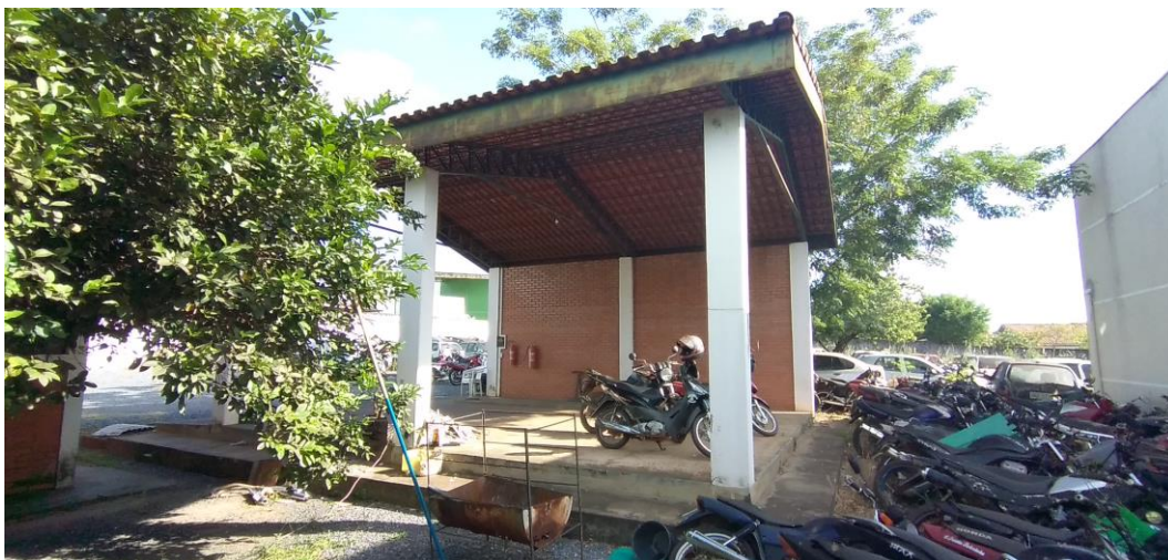
Foto 25: Área de Vistoria
