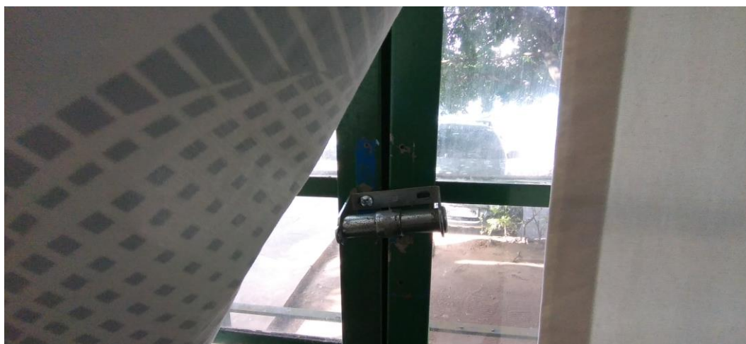
Foto 73: Trinco da Janela Danificado
