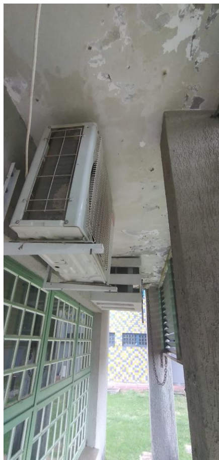
Fotos 10, 11 e 12: Laje do Corredor Lateral Danificada
