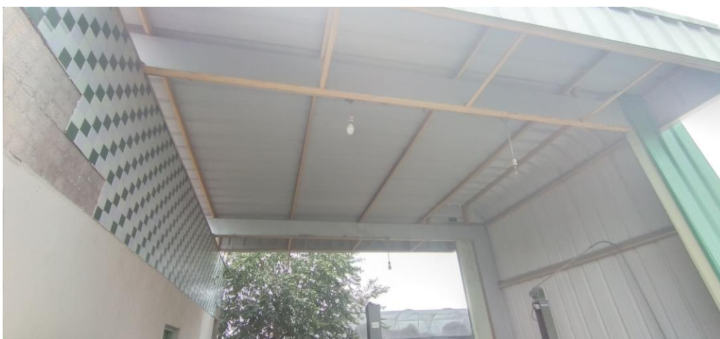
Foto 22: Telhado da Área de Vistoria
