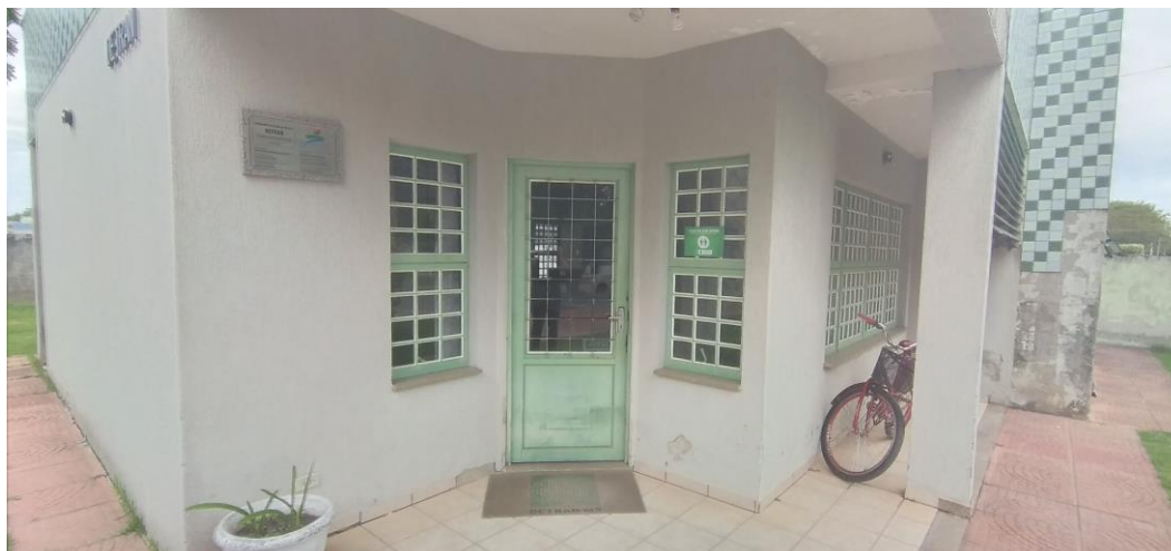
Foto 14: Porta de Acesso Principal
