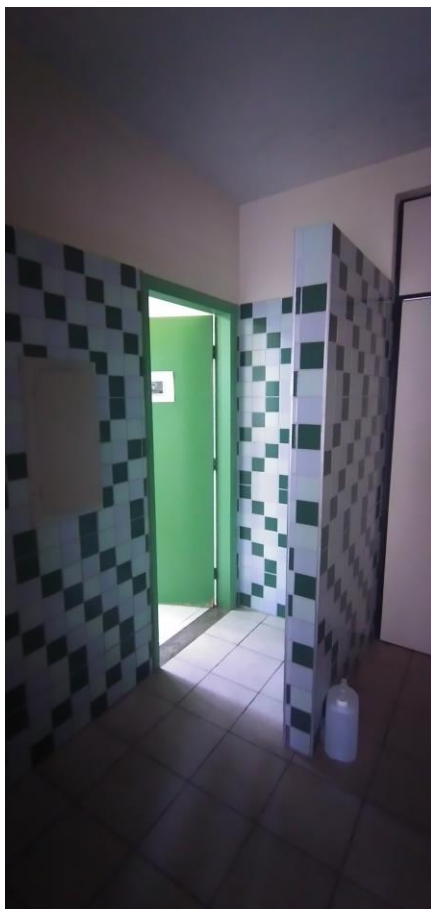
Foto 49: Entrada Banheiro Feminino
