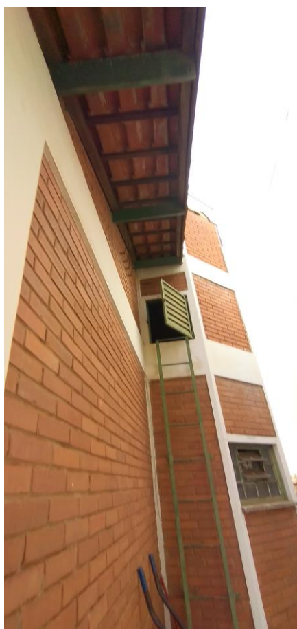
Foto 91: Beiral da Fachada Lateral e Acesso a Caixa de Água
