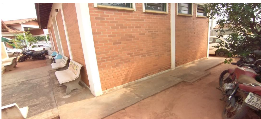
Foto 33: Fachada Lateral da Edificação Anexa ao Prédio Principal
