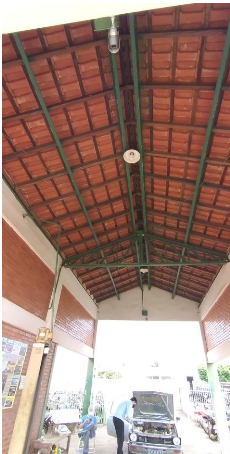
Foto 13: Telhado da Área de Vistoria
