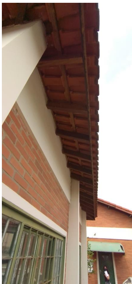
Foto 39: Beiral da Edificação Anexa
