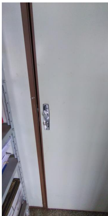
Fotos 135 e 136: Maçanete e Fechadura do Administrativo Danificada
