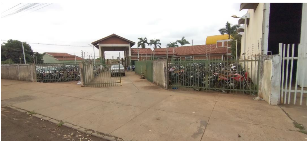
Foto 6: Portão de Acesso para Área de Vistoria
