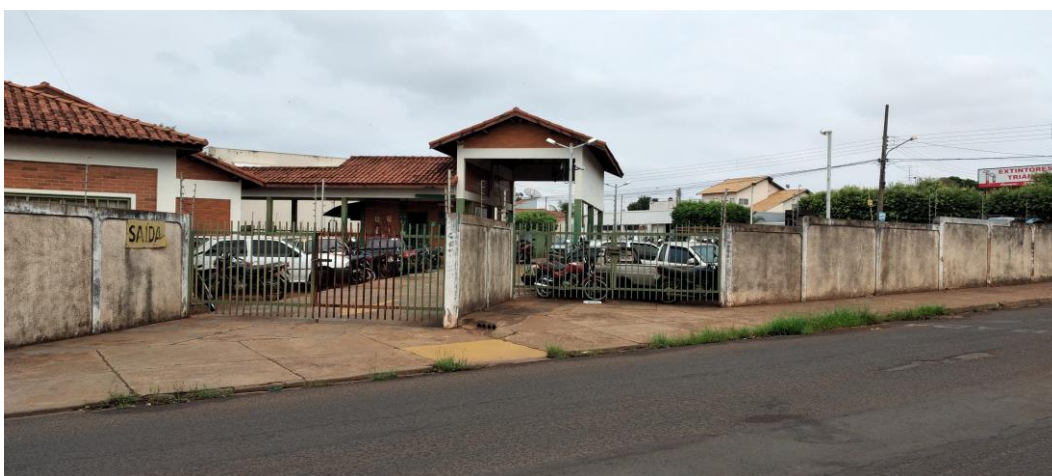
Foto 5: Portão de Acesso para Área de Vistoria
