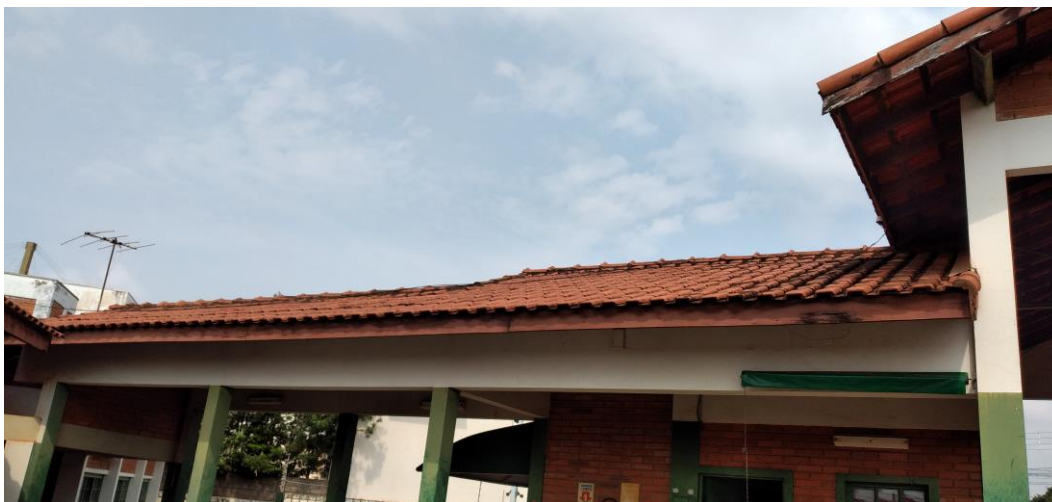
Foto 87: Telhado do Corredor de Acesso a Área de Vistoria
