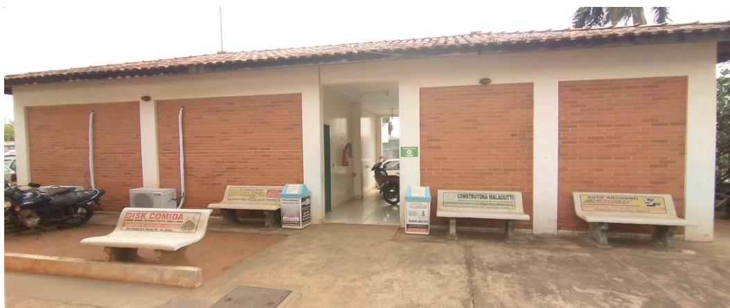
Foto 32: Fachada Frontal da Edificação Anexa ao Prédio Principal
