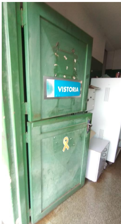
Foto 20: Porta da Sala de Vistoria
