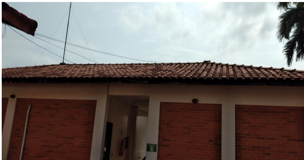
Foto 43: Telhado da Edificação Anexa
