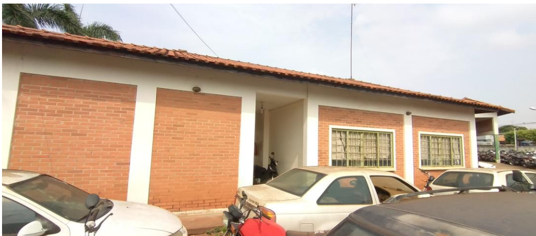
Foto 34: Fachada Posterior da Edificação Anexa ao Prédio Principal
