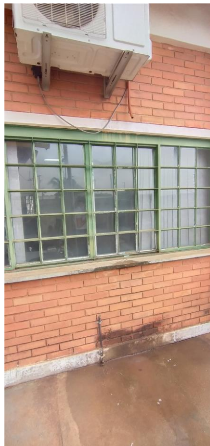
Foto 101: Janela na Fachada Frontal
