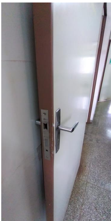
Fotos 135 e 136: Maçanete e Fechadura do Administrativo Danificada
