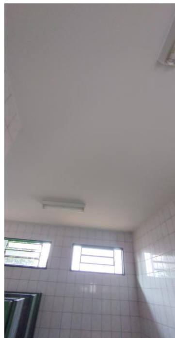
Foto 68: Lage do Banheiro Feminino
