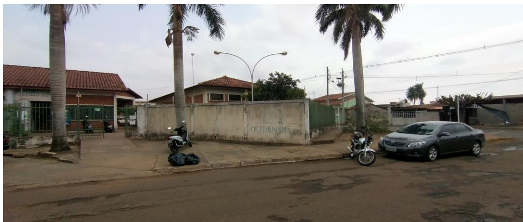
Foto 2: Fachada Frontal Externa
