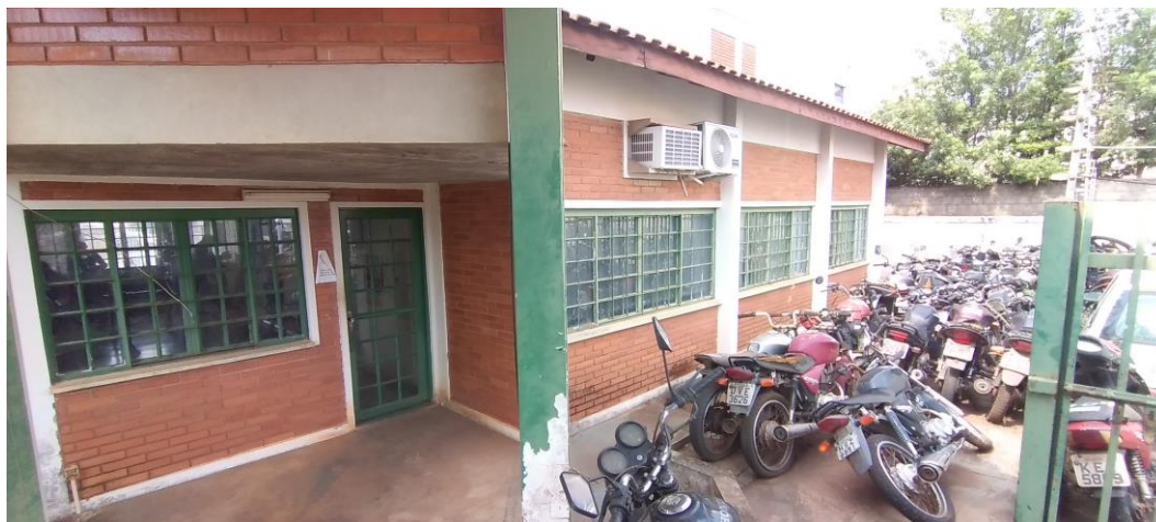
Foto 83: Porta de Acesso a Área de Vistoria e Fachada Fundos
