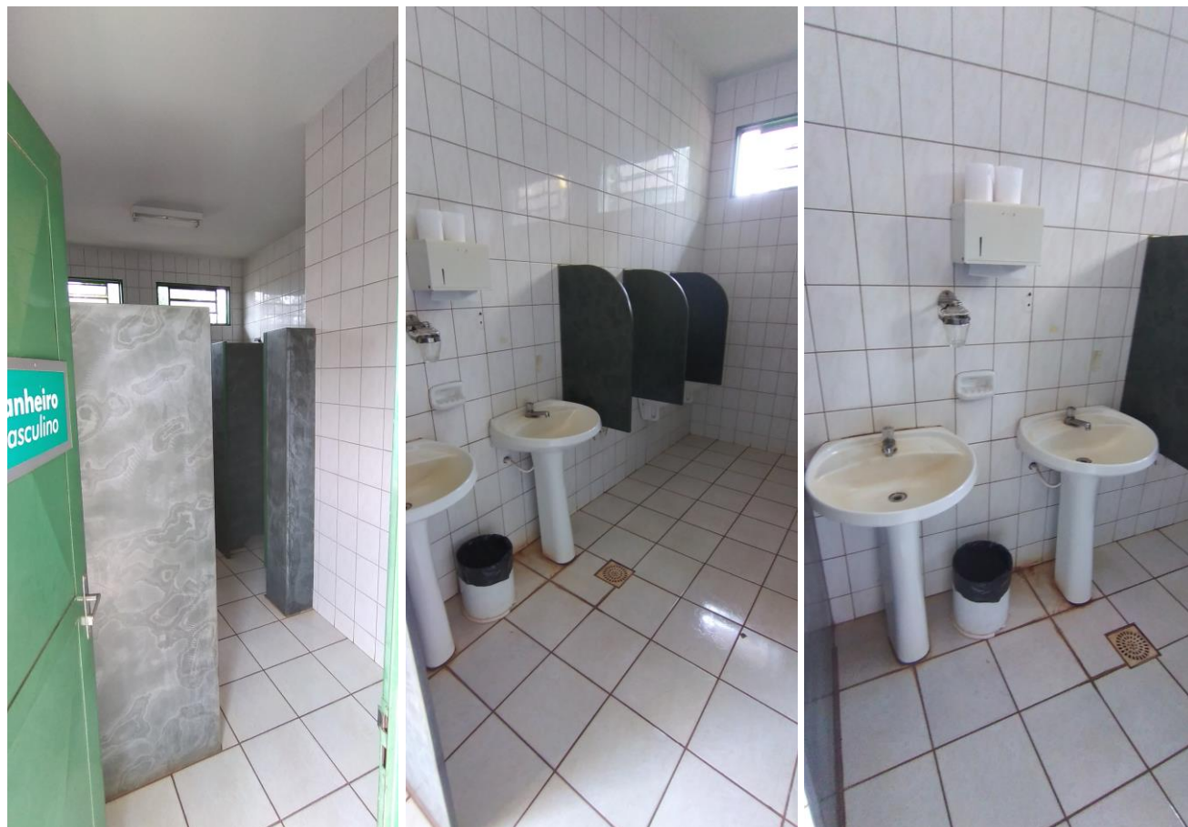
Foto 44, 45 e 46: Banheiro Masculino Externo
