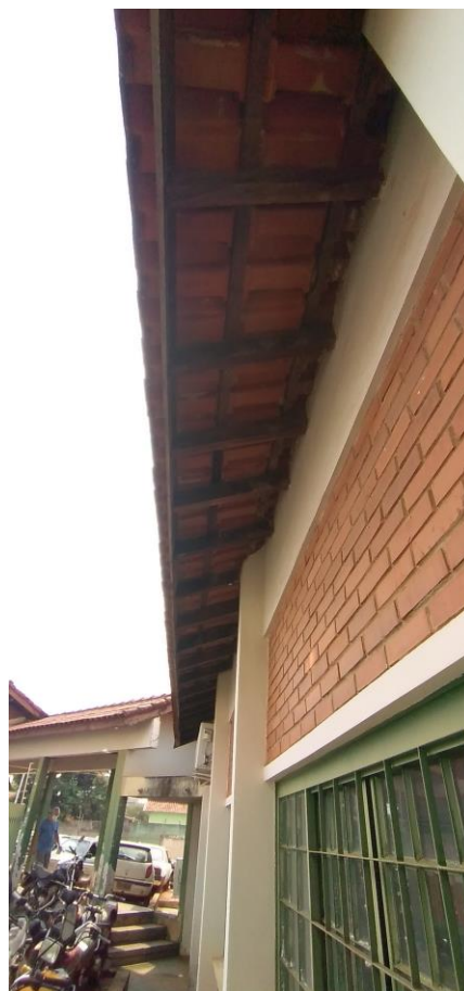
Foto 89: Beiral da Fachada Posterior
