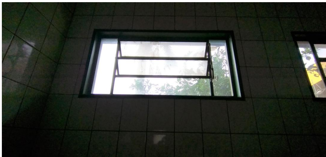
Foto 51: Janela Banheiro Masculino Externo
