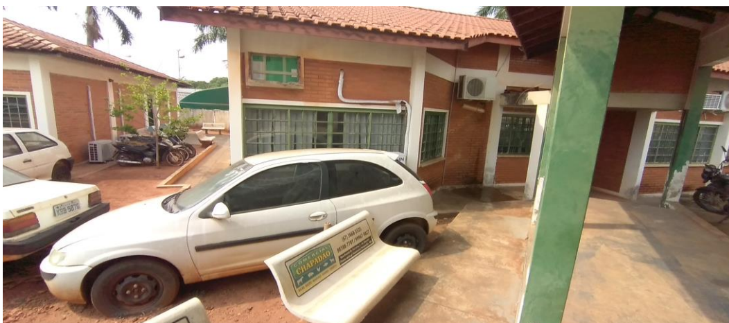
Foto 81: Fachada Posterior do Prédio Principal
