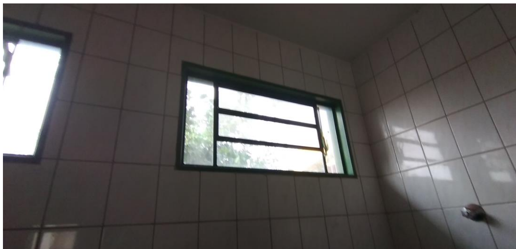
Foto 55: Janela Banheiro Masculino Externo
