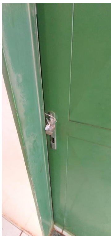
Foto 61: Maçaneta Danificada
