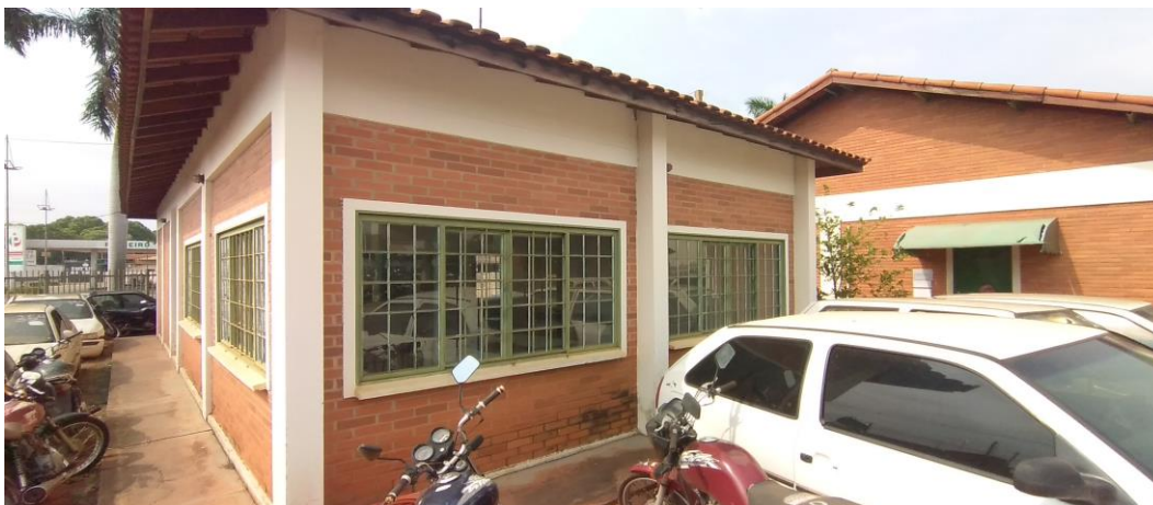
Foto 35: Fachada Lateral da Edificação Anexa ao Prédio Principal
