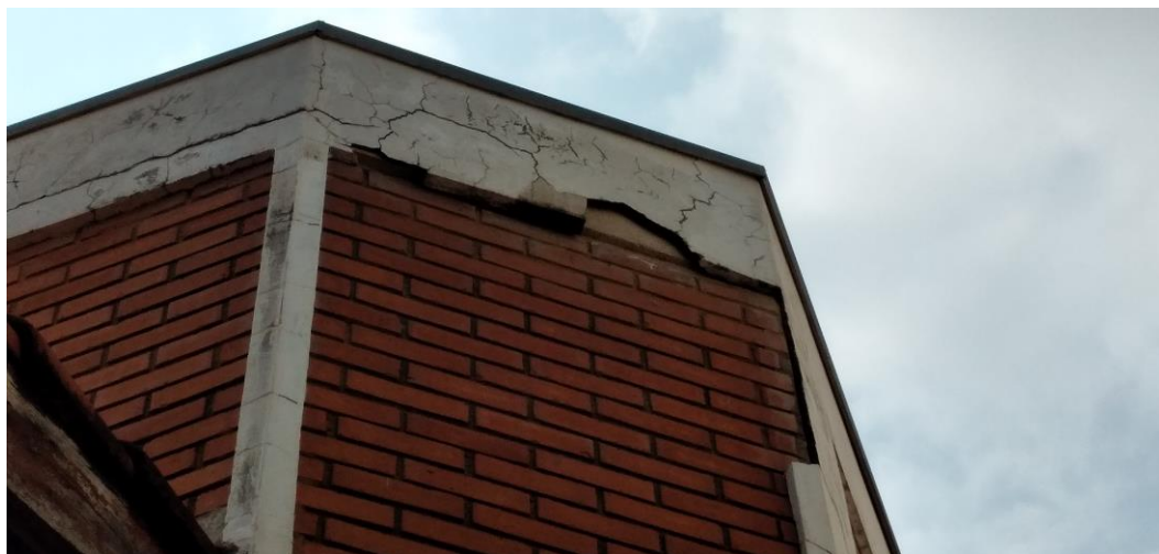
Foto 94: Volume da Caixa de Água com Reboco Danificado
