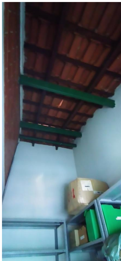
Foto 26: Telhado do Arquivo
