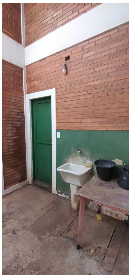
Foto 95: Área de Serviço
