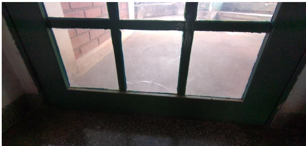
Foto 114: Porta de Acesso à Área de Vistoria Danificada
