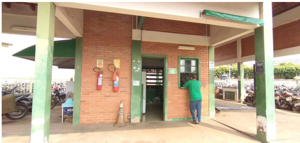
Foto 19: Fachada da Sala de Vistoria
