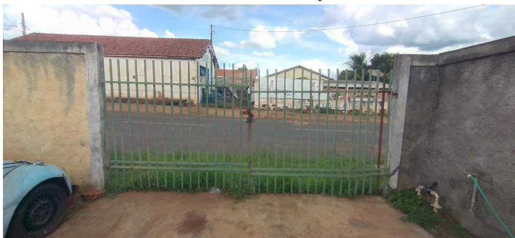
Foto 19: Portão de Acesso ao Pátio de Veículos Apreendidos
