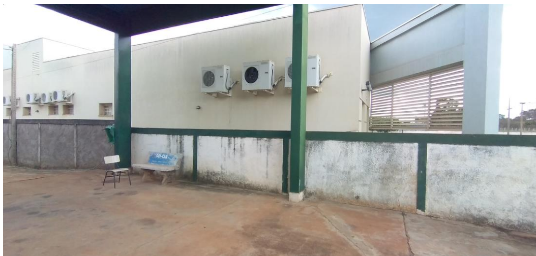
Foto 15: Área de Vistoria
