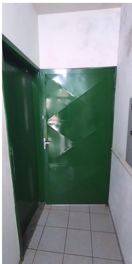
Foto 49: Porta de Acesso a Área de Atendimento
