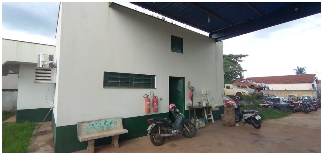
Foto 14: Área de Vistoria
