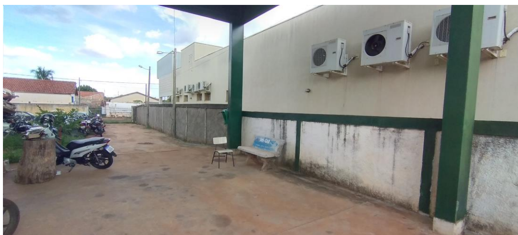
Foto 16: Área de Vistoria
