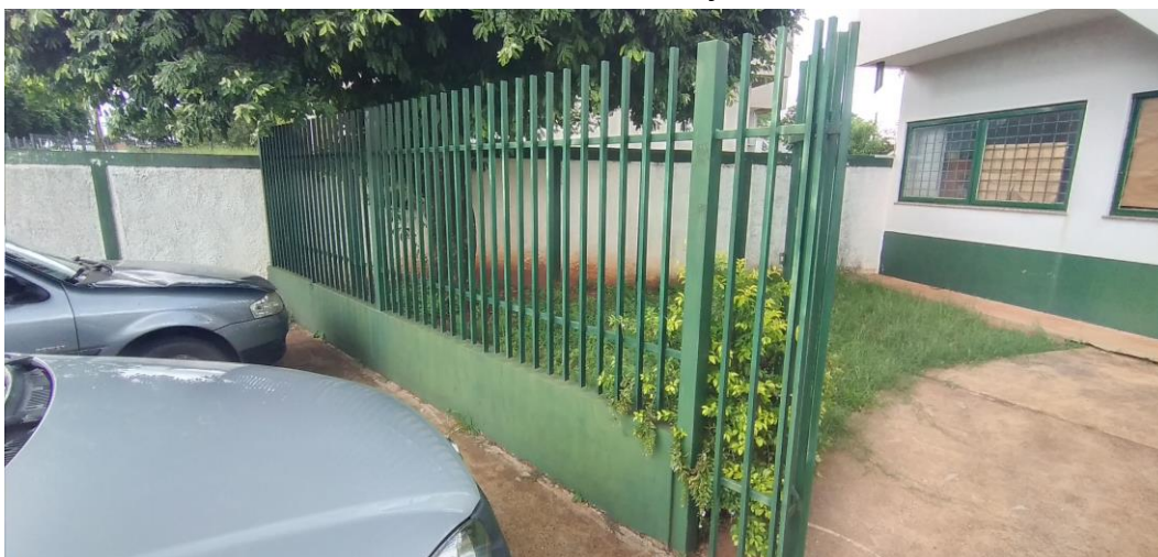
Foto 2: Grade de Delimitação do Terreno
