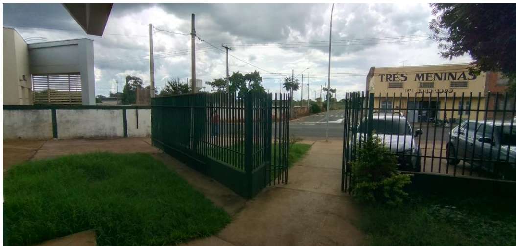
Foto 12: Grade de Delimitação do Terreno
