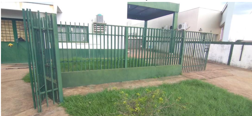
Foto 3: Grade de Delimitação do Terreno
