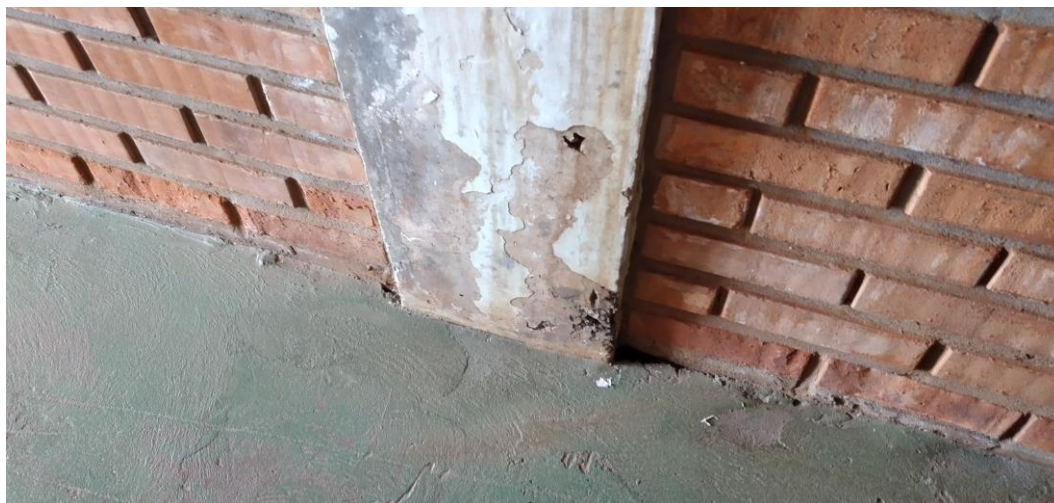
Foto 72: Pilar corredor de acesso ao exterior
