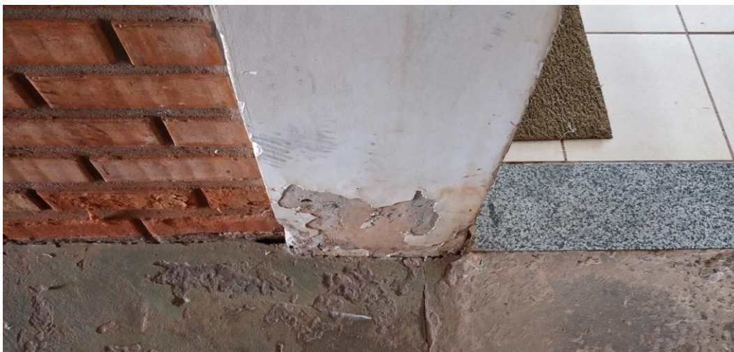
Foto 73: Pilar corredor de acesso ao exterior
