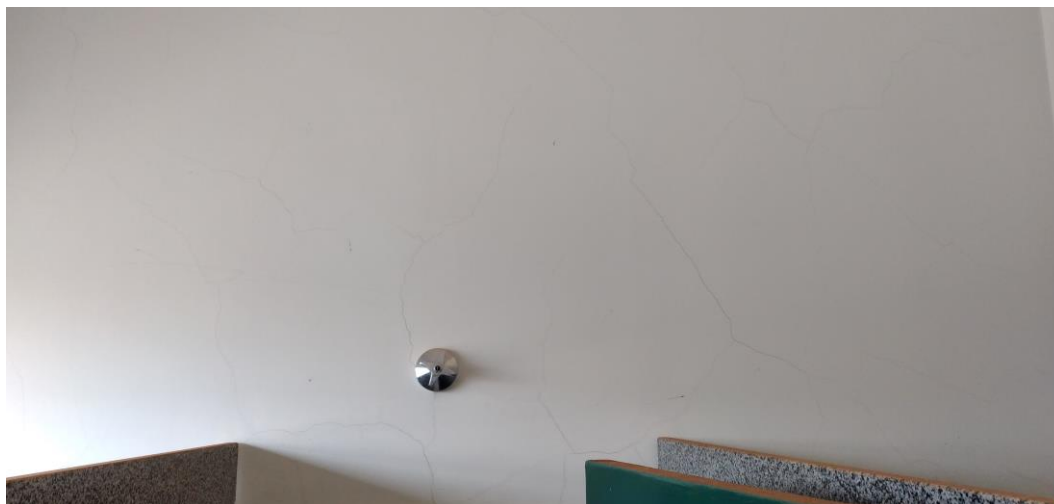
Foto 112: Parede banheiro masculino
