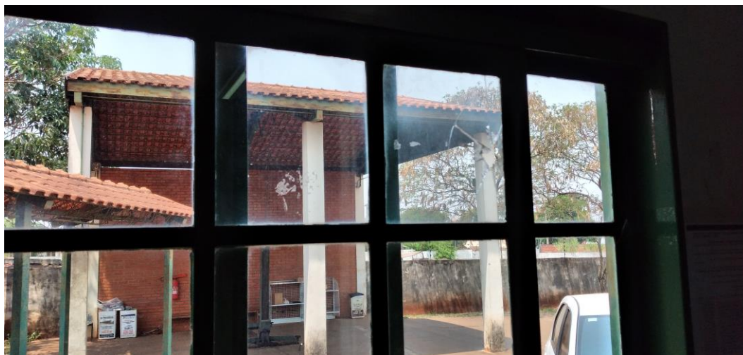
Foto 63: Janela sala de arquivo
