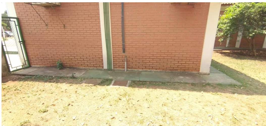
Foto 130: Calçada interna lateral
