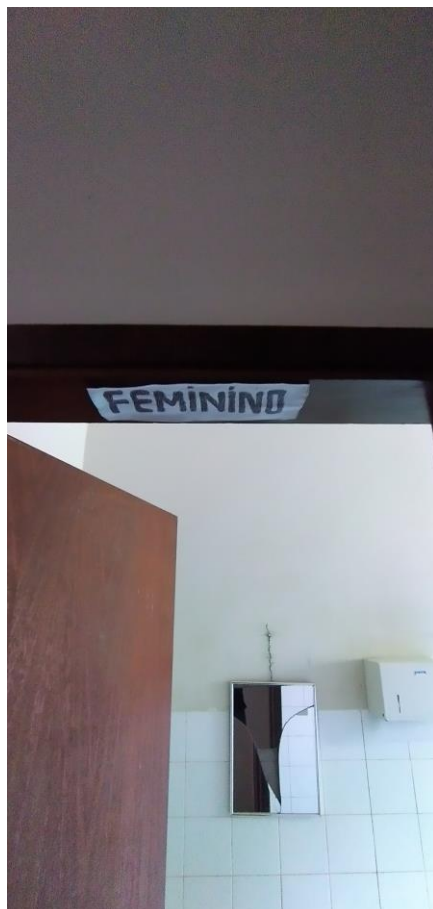
Foto 47: Porta banheiro feminino
