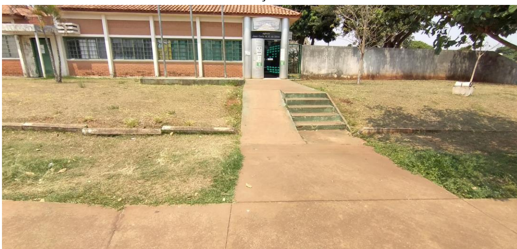
Foto 6: Escada externa de acesso
