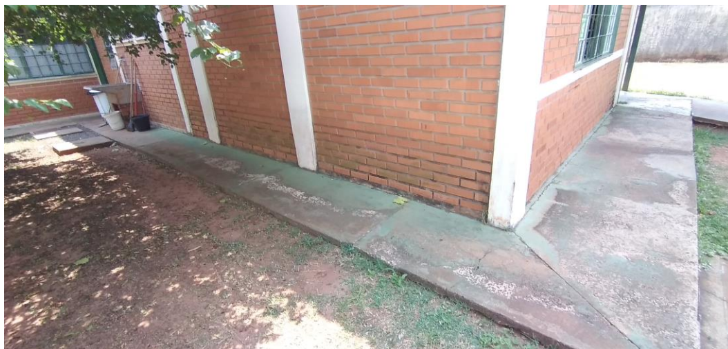
Foto 137: Calçada interna traseira
