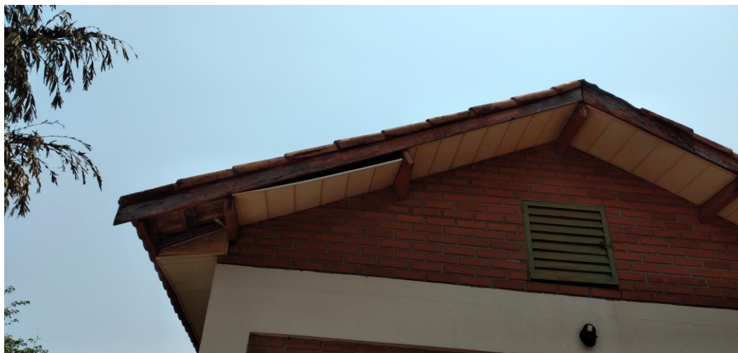
Foto 140: Forro externo fachada traseira
