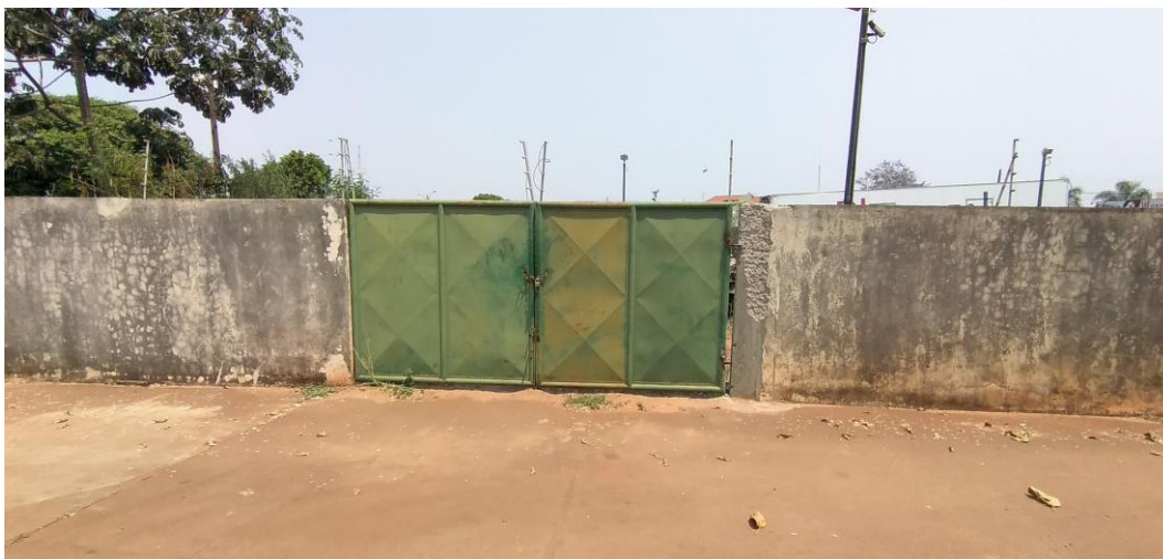
Foto 151: Portão interno de acesso ao pátio para carros apreendidos
