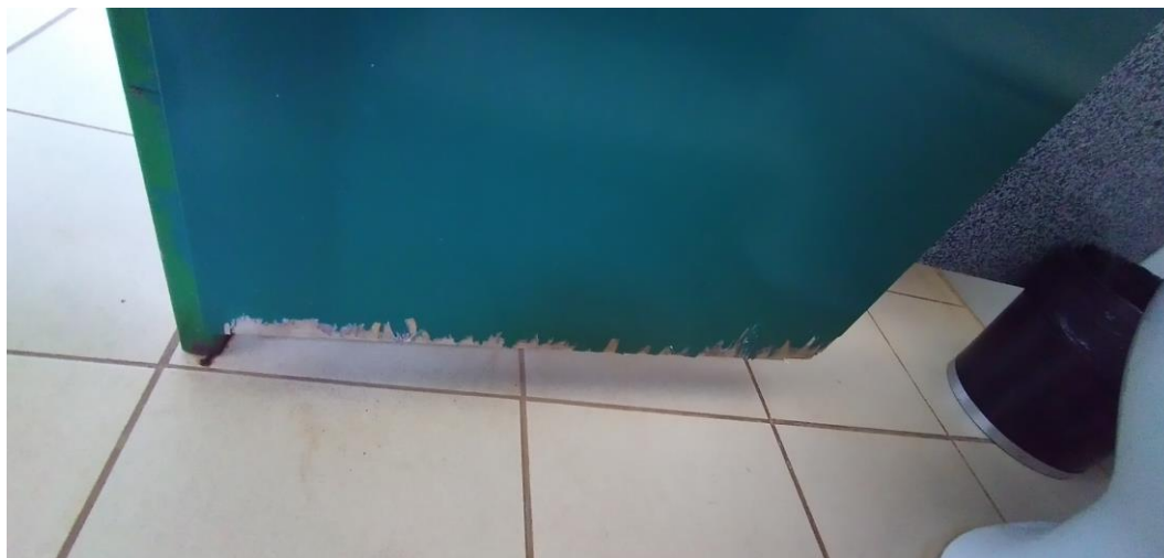
Foto 86: Porta sanitário banheiro feminino
