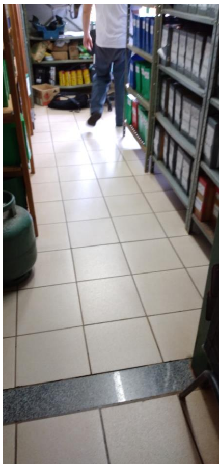
Foto 66: Chão sala de arquivo
