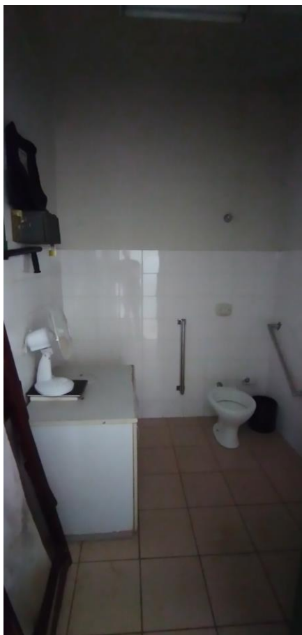
Foto 94: Banheiro de deficientes
