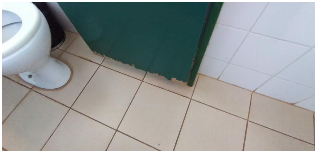
Foto 85: Porta sanitário banheiro feminino
