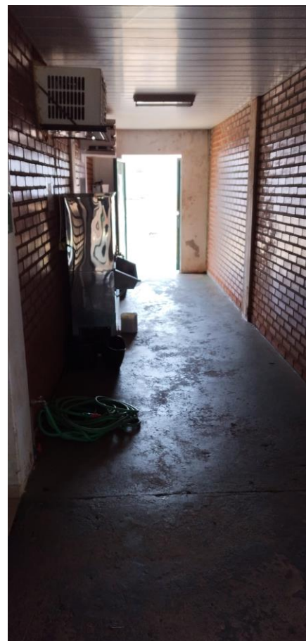
Foto 67: Corredor de acesso ao exterior
