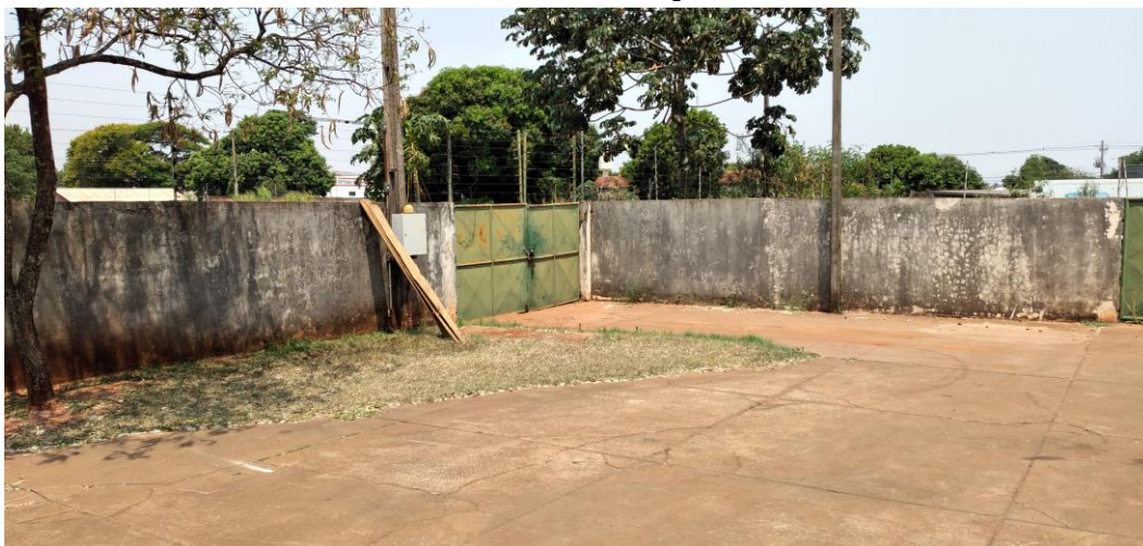
Foto 153: Portão interno de acesso ao pátio para carros apreendidos
