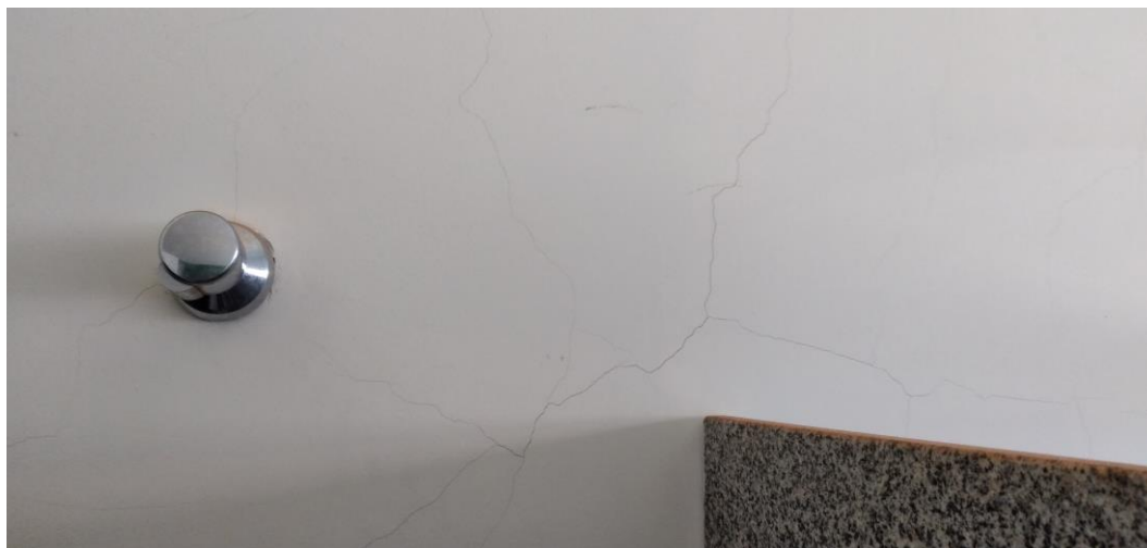
Foto 90: Parede banheiro feminino
