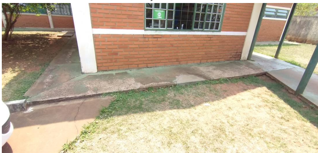
Foto 138: Calçada interna traseira
