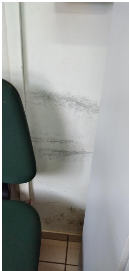
Foto 65: Parede sala de arquivo
