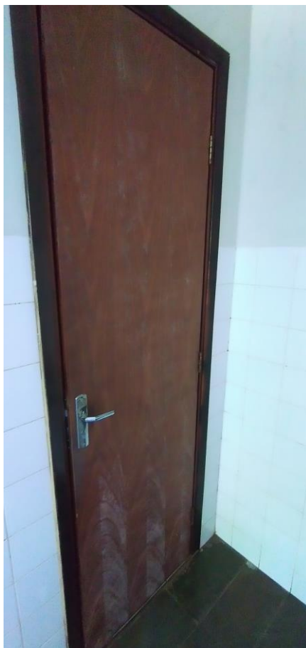
Foto 53: Porta banheiro feminino
