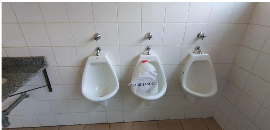
Foto 105: Mictórios banheiro masculino
