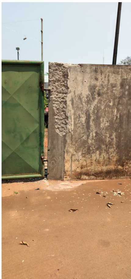
Foto 152: Muro ao lado do portão interno
