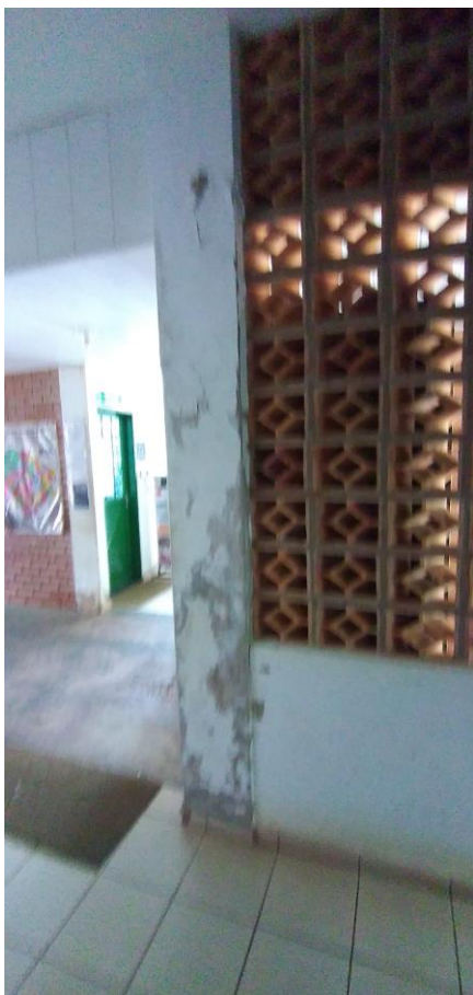
Foto 55: Corredor de acesso
