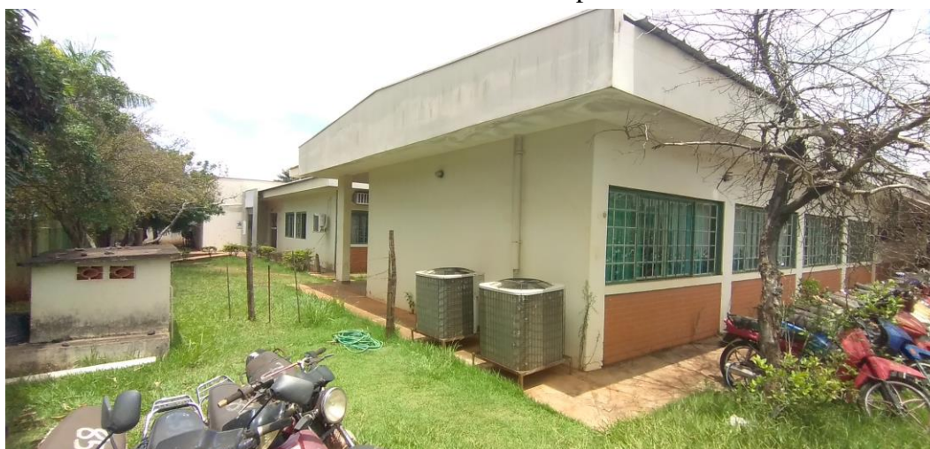
Foto 48: Fachada Lateral do Bloco de Sala de Aula
