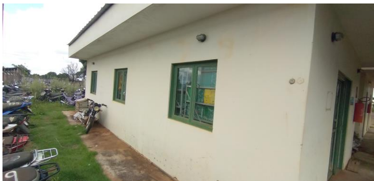
Foto 43: Fachada Lateral do Arquivo Externo
