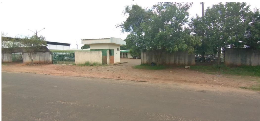
Foto 15: Portões de Acesso ao Pátio Interno
