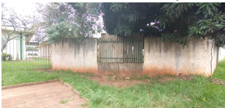
Foto 6: Gradil metálico/ Muro externo e Calçada externa
