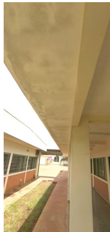
Foto 63: Beiral da Área de Circulação Danificado
