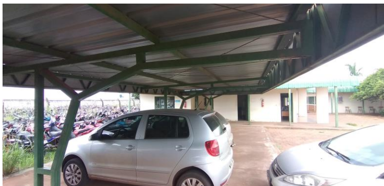
Foto 42: Cobertura do Estacionamento
