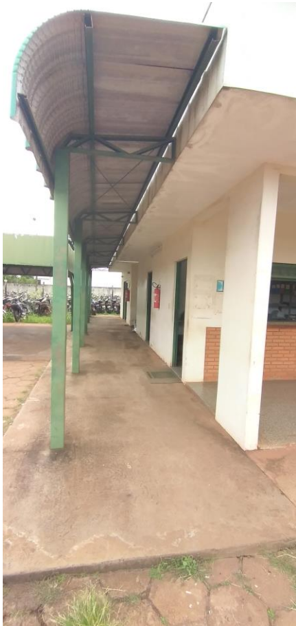
Foto 51: Fachada Frontal do Bloco de Sala de Aula
