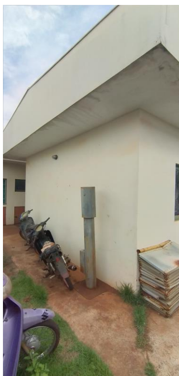
Foto 44: Fachada Posterior do Arquivo com Beiral Danificado
