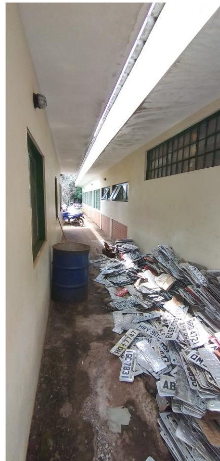
Foto 52: Fachada Lateral e Corredor lateral
