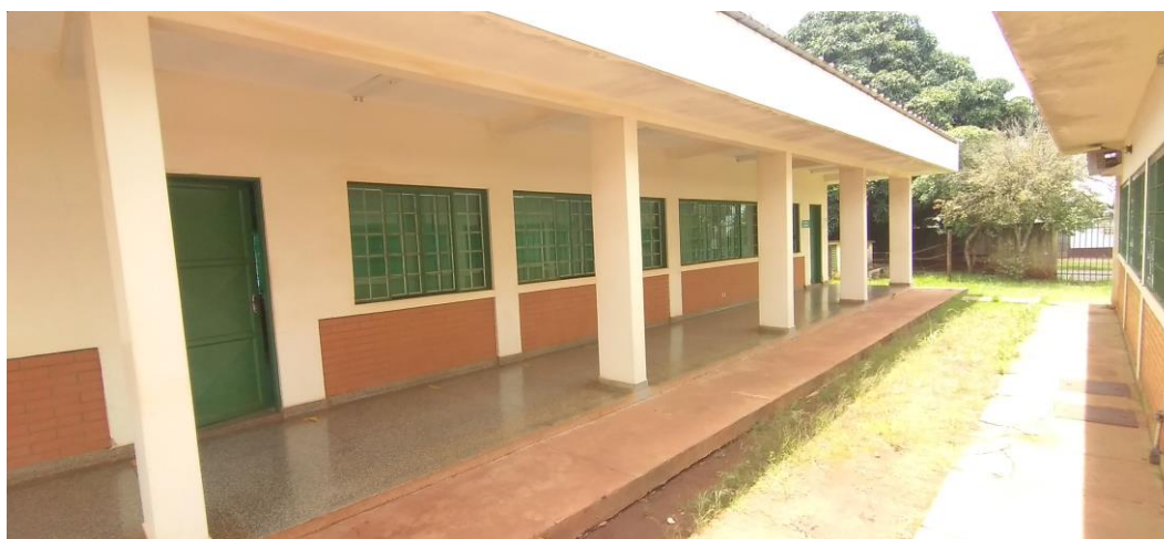
Foto 49: Fachada Lateral do Bloco de Sala de Aula
