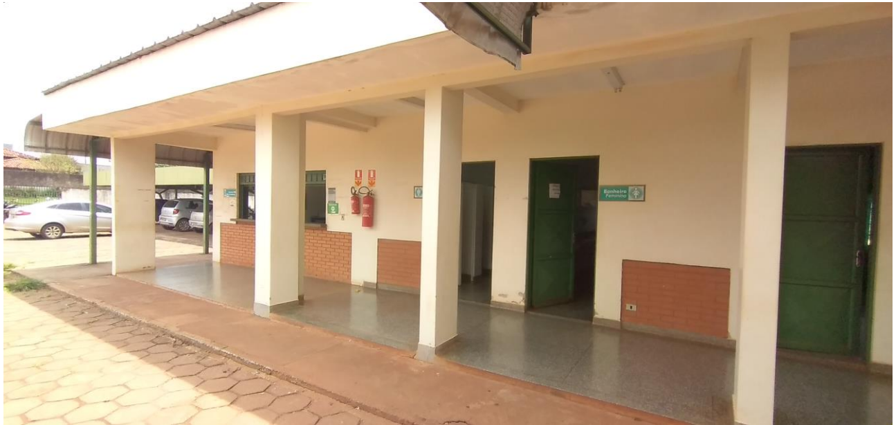
Foto 50: Fachada Lateral do Bloco de Sala de Aula
