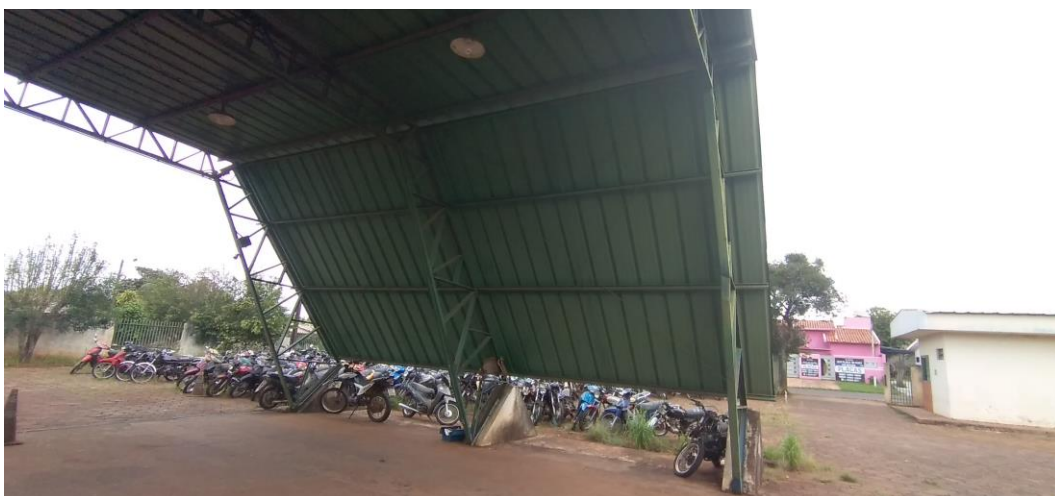
Foto 112: Cobertura Lateral da Área de Vistoria
