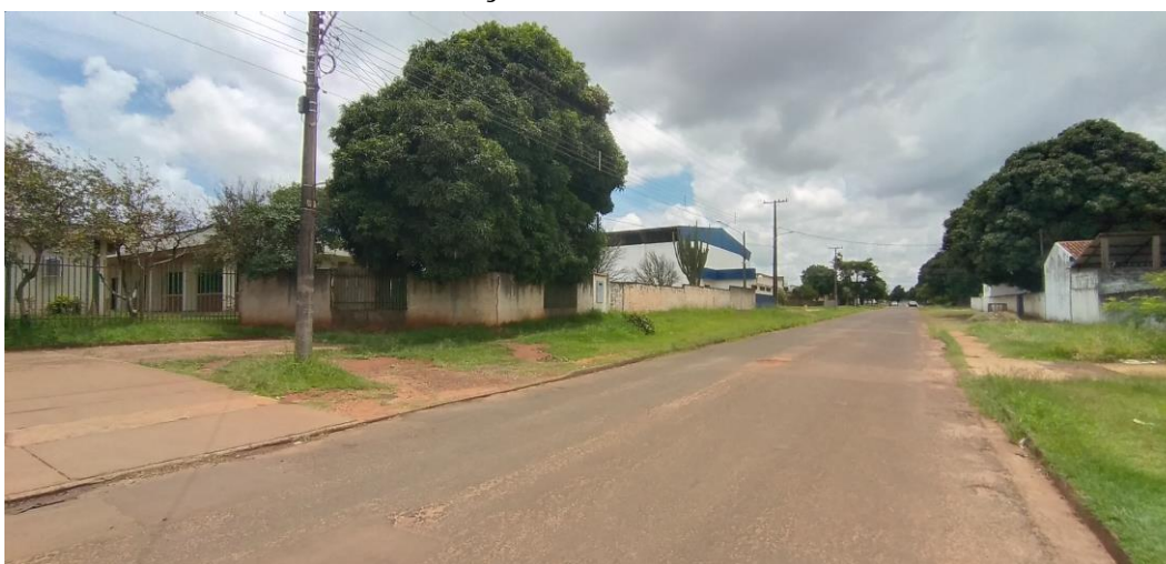
Foto 2: Calçada Externa Danificada
