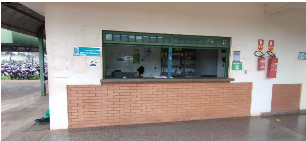
Foto 98: Janela de Atendimento da Sala de Vistoria
