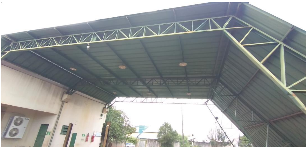
Foto 111: Telhado da Área de Vistoria
