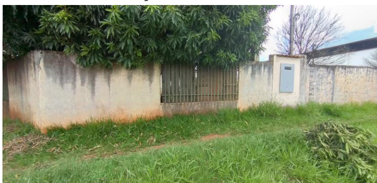
Foto 5: Gradil metálico/ Muro externo e Calçada externa
