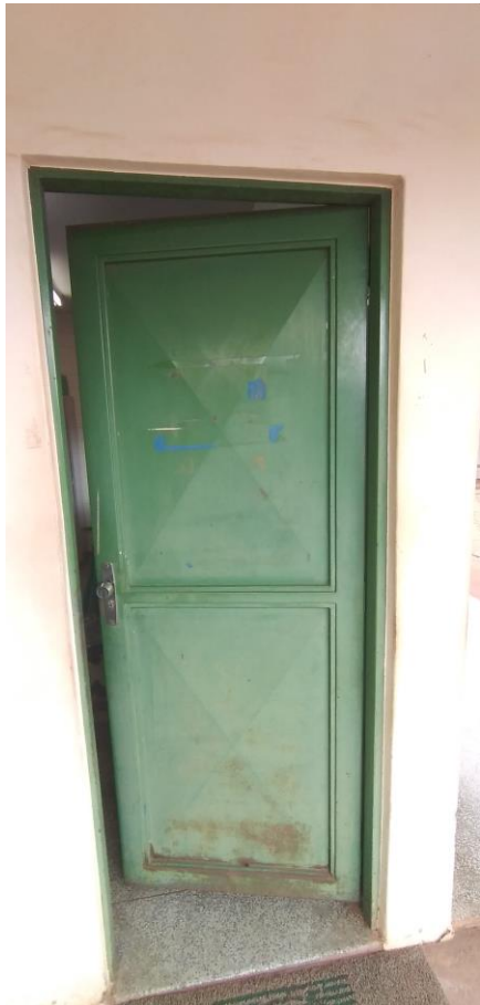
Foto 99: Porta de Acesso a Sala da Vistoria
