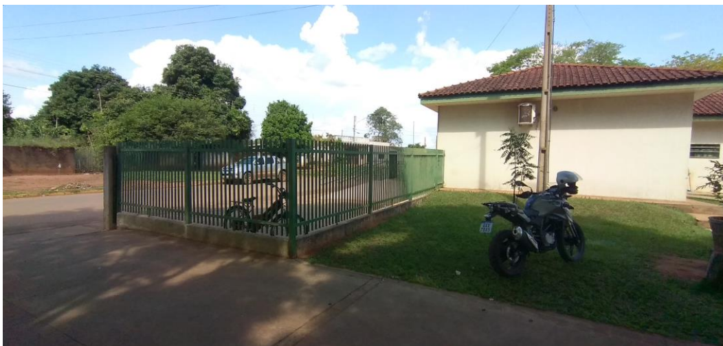
Foto 26: Gradil Metálico da Fachada Frontal
