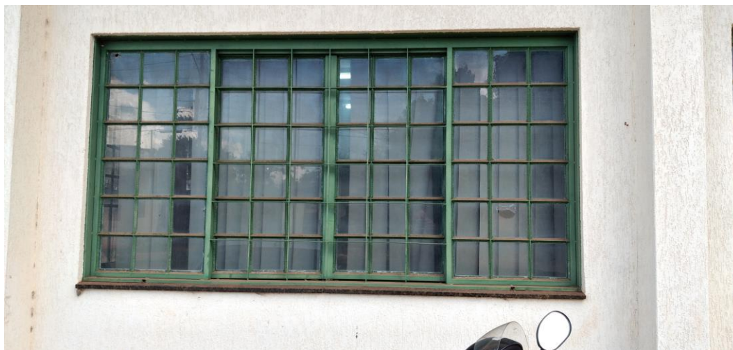
Foto 11: Janela na Fachada Frontal
