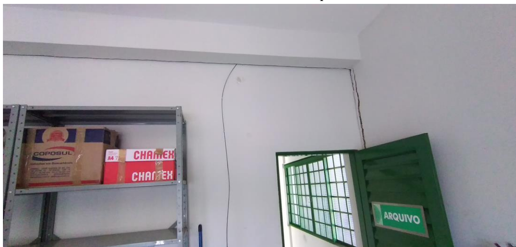
Foto 107: Fiação Aparente no Arquivo
