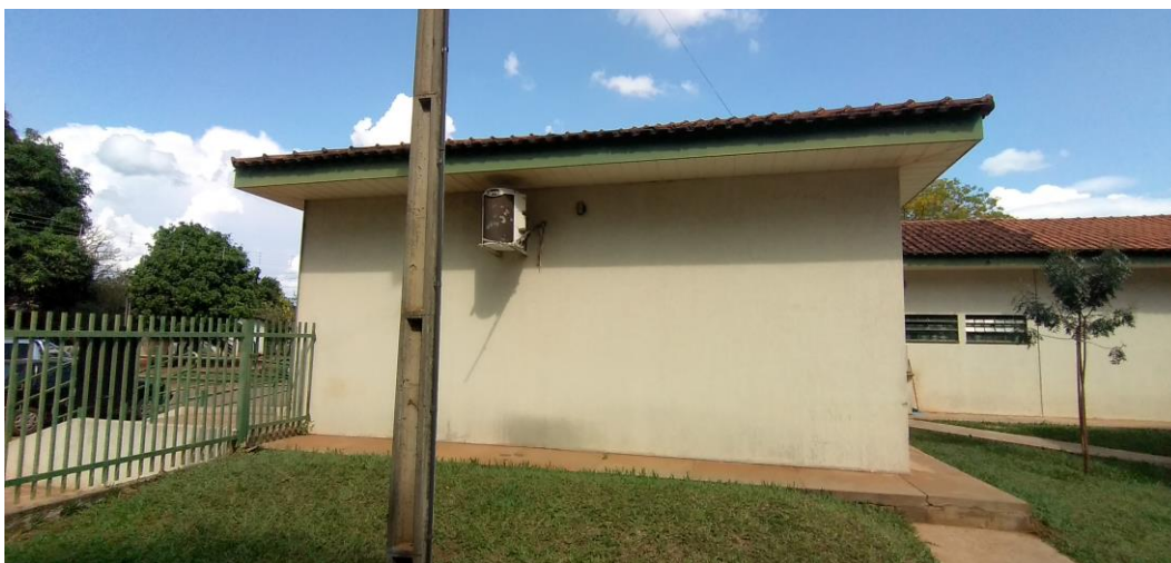
Foto 27: Fachada Lateral Interna
