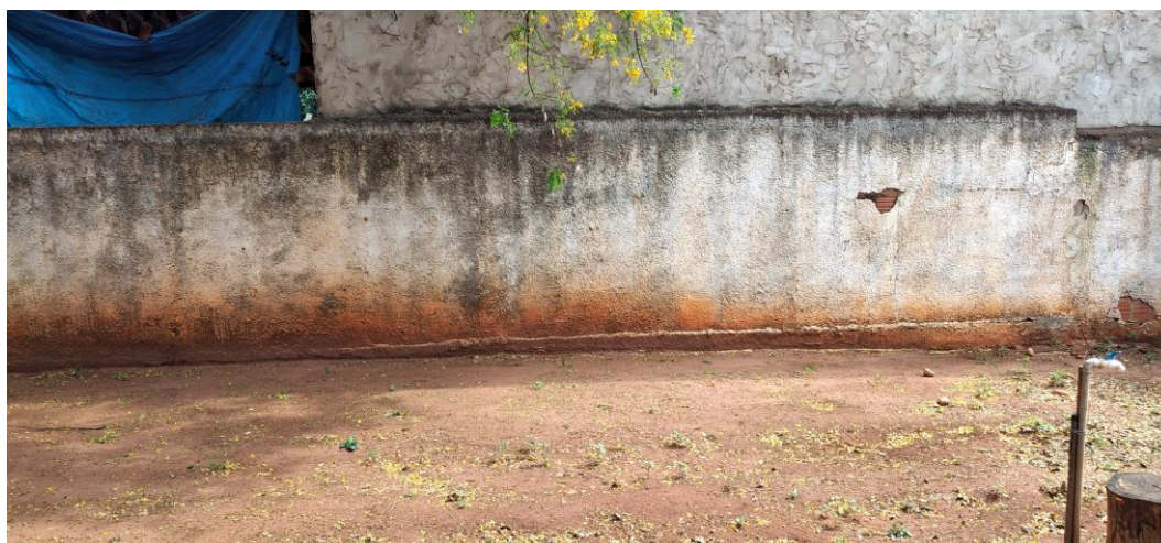
Foto 47: Muro Interno e Pátio Interno
