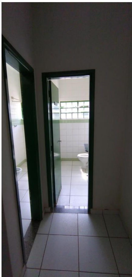
Foto 85: Área de Circulação
