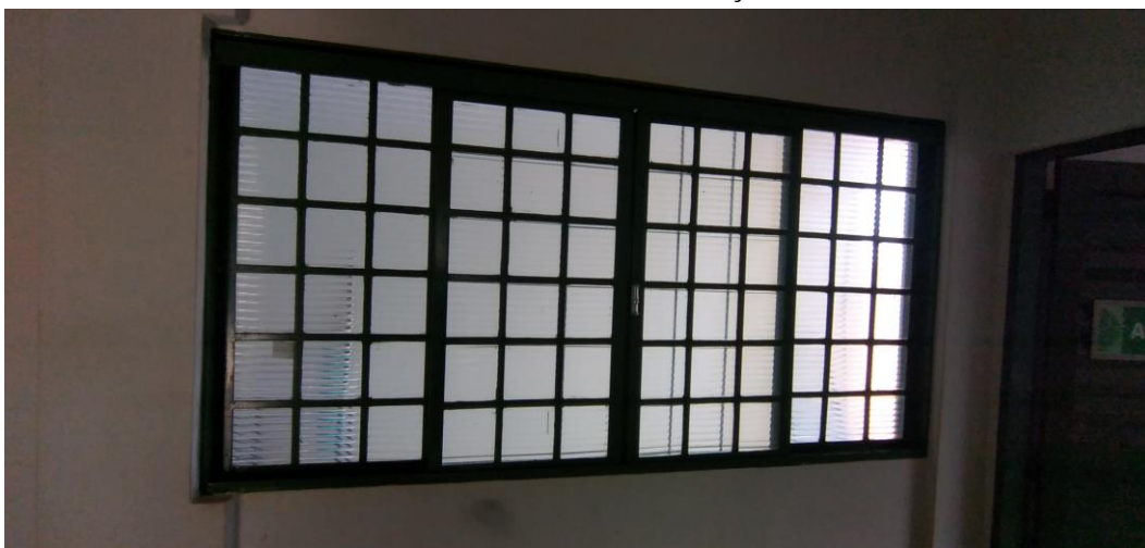
Foto 113: Janela na Área de Circulação
