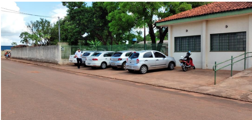
Foto 2: Fachada Frontal e Estacionamento
