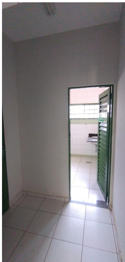
Foto 137: Área de Circulação
