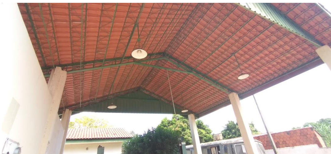
Foto 25: Telhado da Área de Vistoria
