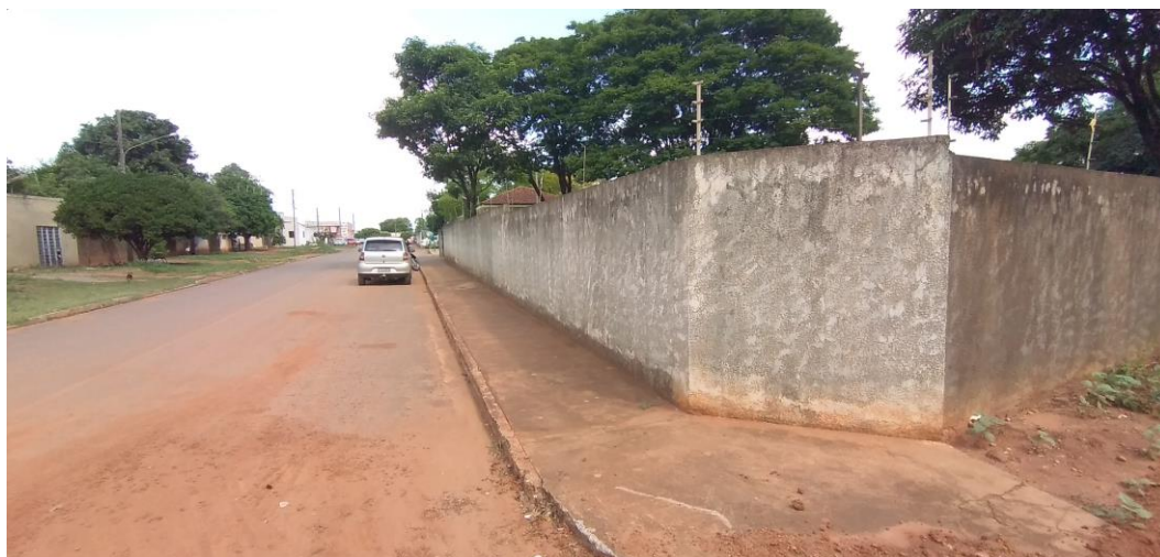
Foto 5: Muro e Calçada Externas
