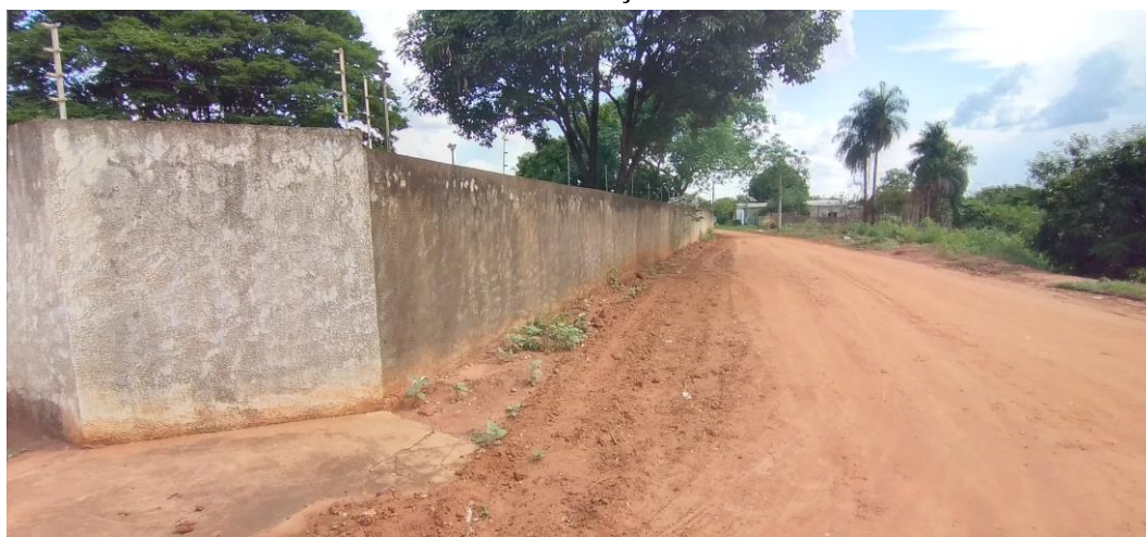
Foto 6: Muro e Calçada Externas
