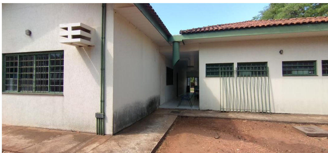
Foto 38: Fachada Posterior e Acesso ao Interior da Agência
