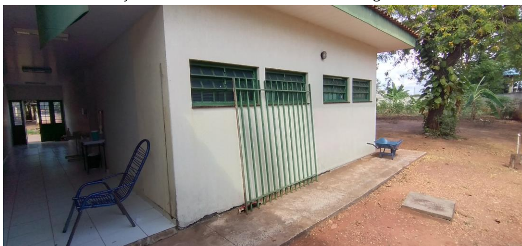
Foto 41: Fachada Posterior e Janelas dos Banheiros
