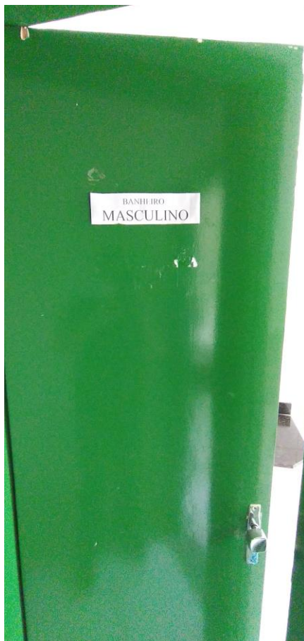
Foto 86: Porta do Banheiro Masculino de Funcionários
