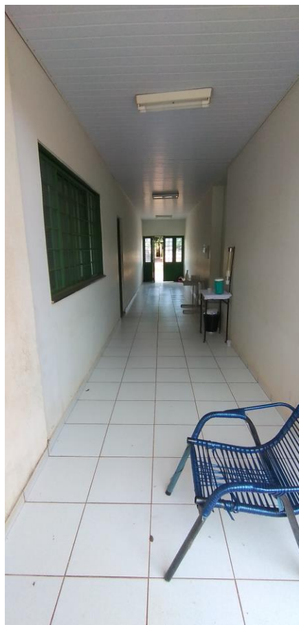
Foto 115: Área de Circulação
