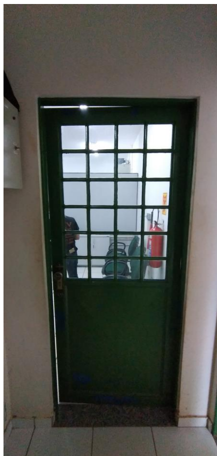
Foto 71: Porta de Acesso Interno
