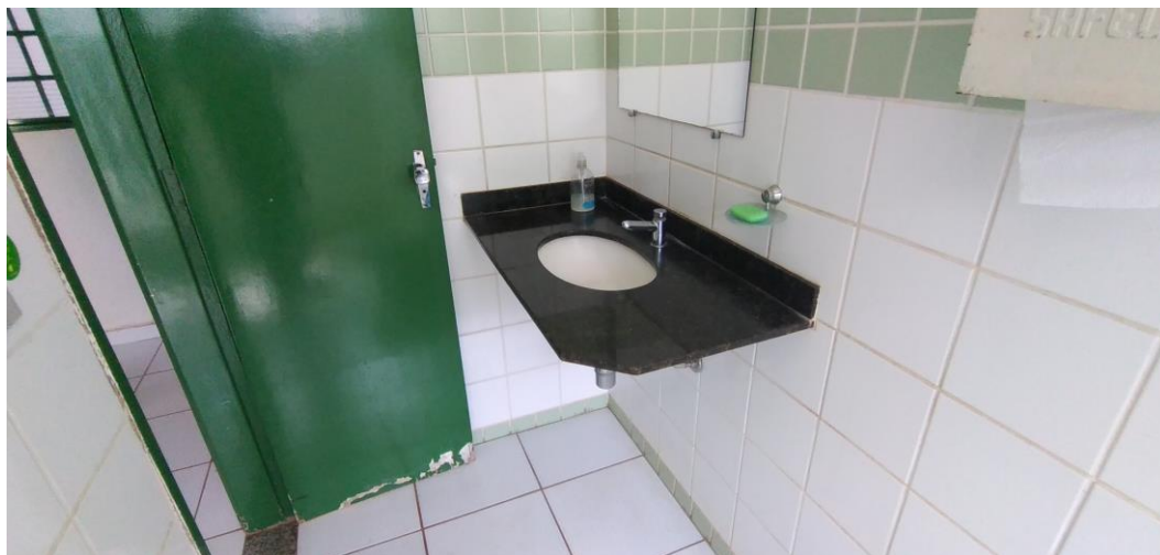
Foto 92: Pia do Banheiro Masculino de Funcionários
