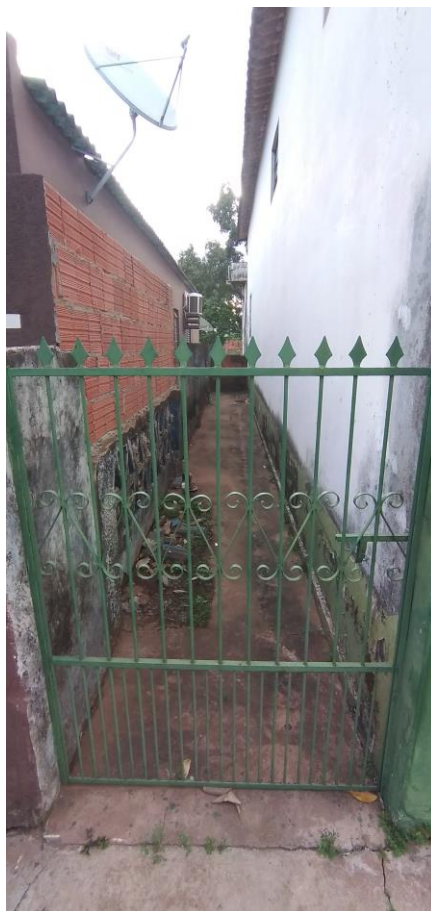
Foto 6: Portão de Acesso ao Corredor Lateral
