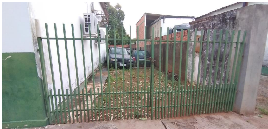
Foto 2: Portão de Acesso Ao Pátio Interno
