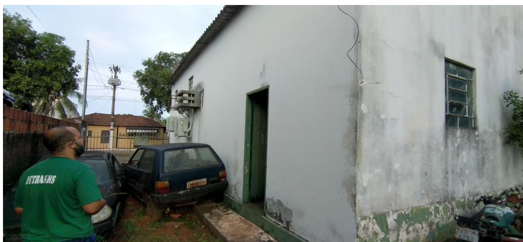
Foto 3: Fachada Lateral Direita e Porta de Acesso
