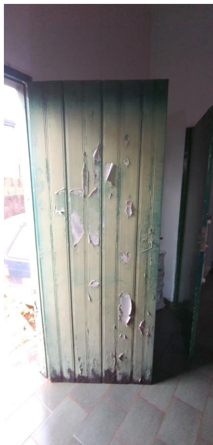
Fotos 50 e 51: Porta de Acesso ao Pátio Externo Danificada
