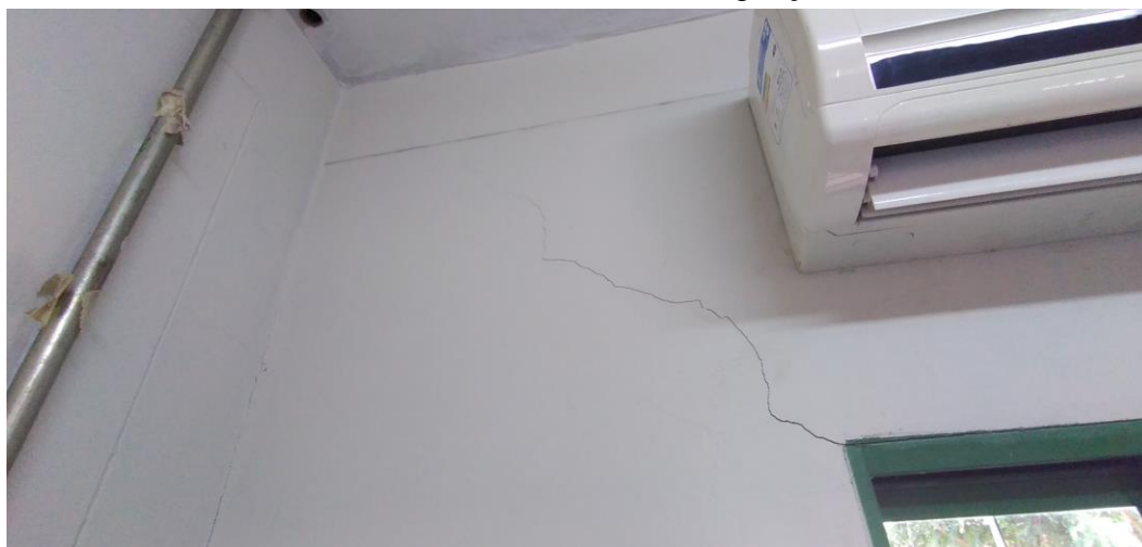
Foto 99: Parede da Sala de Digitação Danificada
