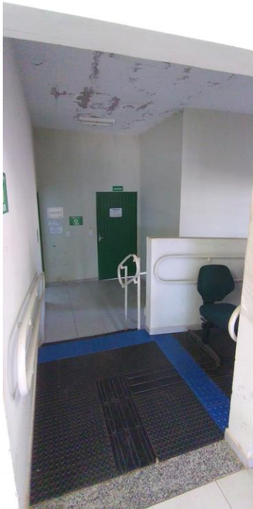
Foto 66: Área de Circulação
