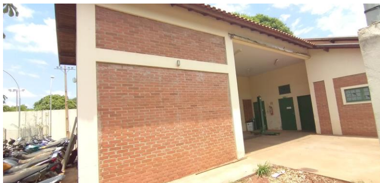
Foto 104: Área de Vistoria
