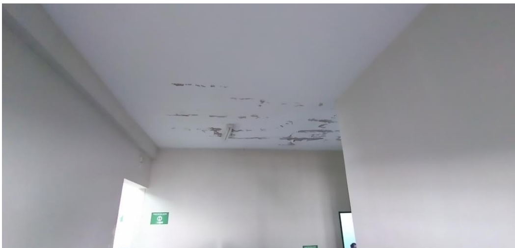
Foto 71: Laje da Rampa de Acessibilidade Danificada
