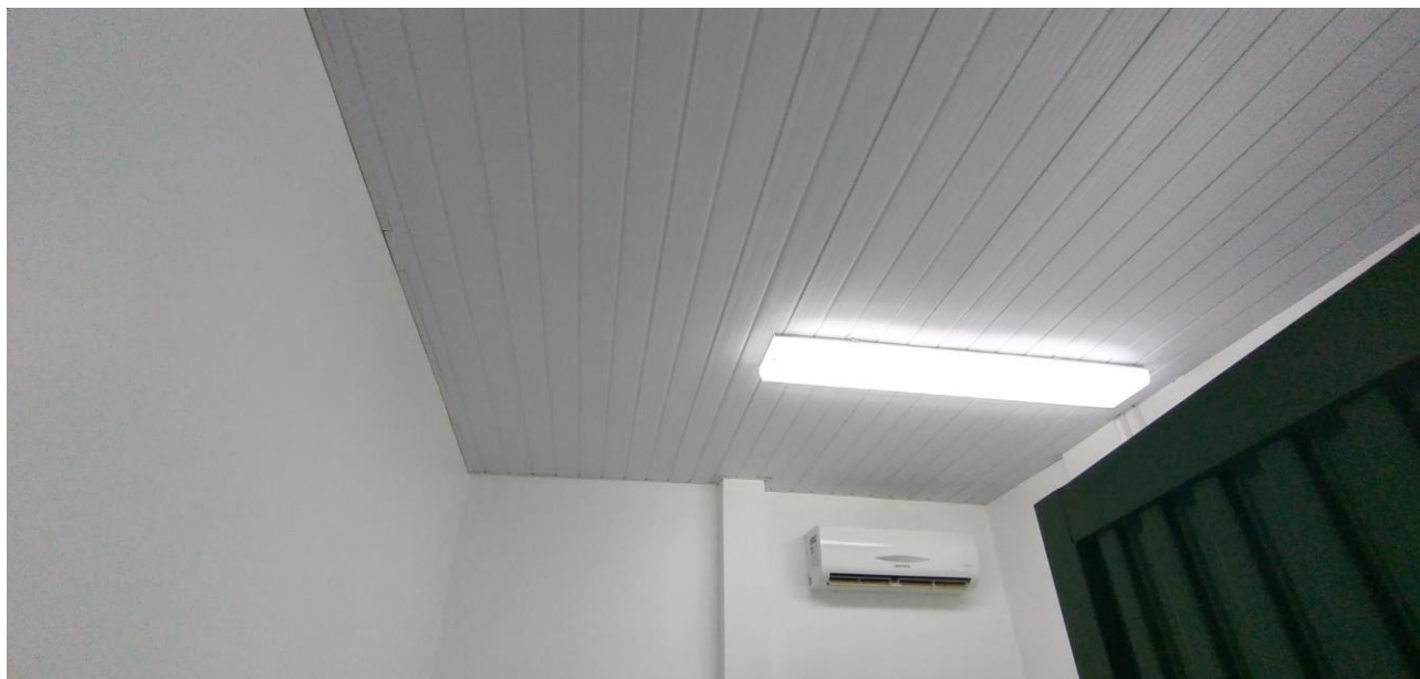
Foto 77: Foro de PVC da Sala de Captura de Imagem
