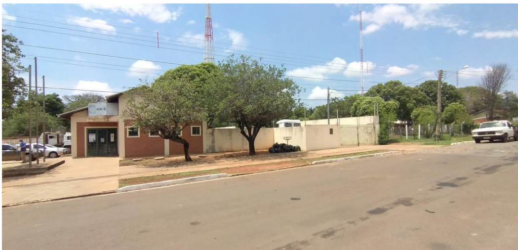
Foto 1: Fachada Lateral Externa
