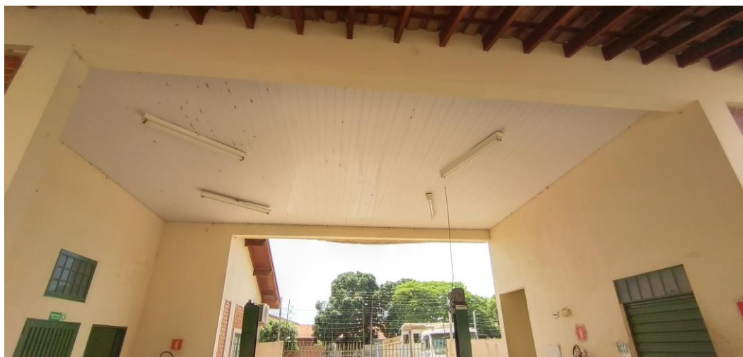
Foto 33: Foro de PVC da Área de Vistoria
