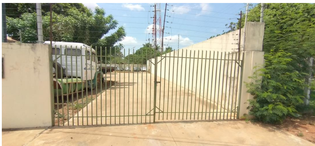
Foto 19: Portão de Acesso ao Pátio Interno
