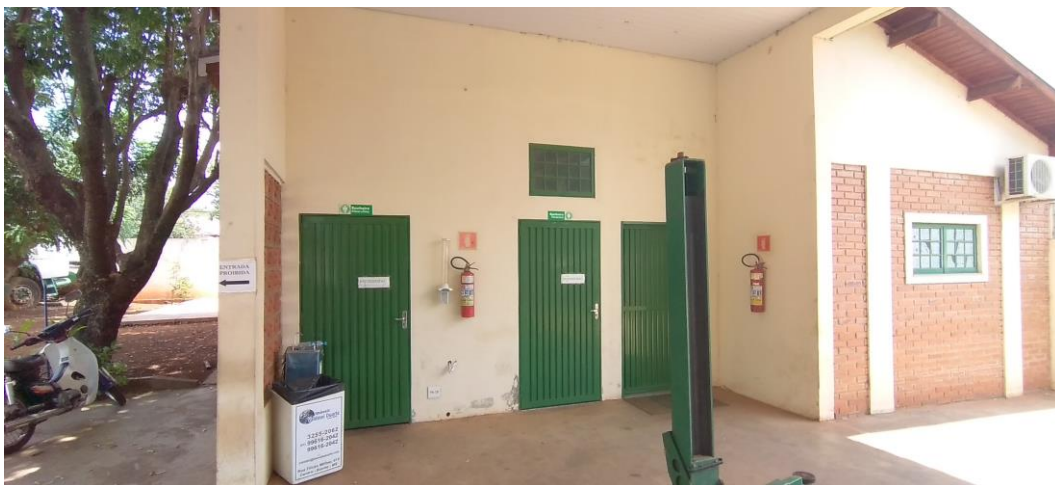
Foto 31: Área de Vistoria
