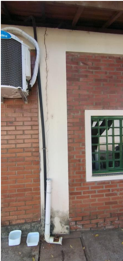
Foto 52: Dreno do Ar-Condicionado
