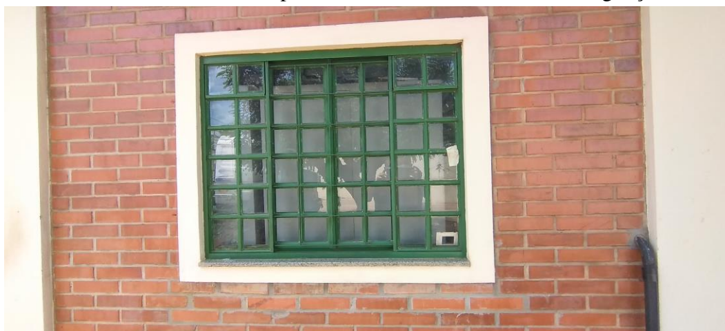
Foto 51: Janela da Área de Circulação
