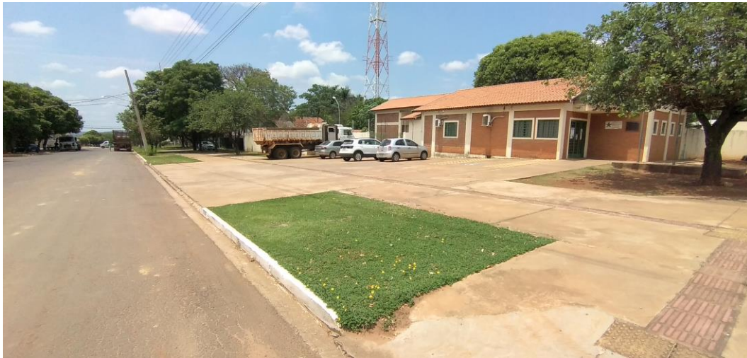
Foto 4: Calçada Externa e Estacionamento
