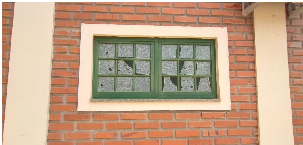
Foto 106: Janela da Sala de Captura de Imagem
