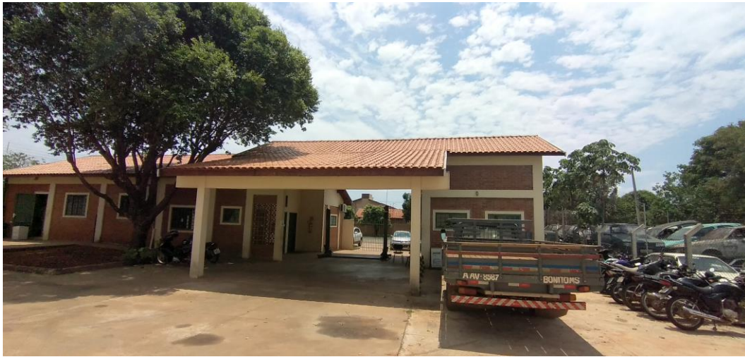
Foto 26: Área de Vistoria
