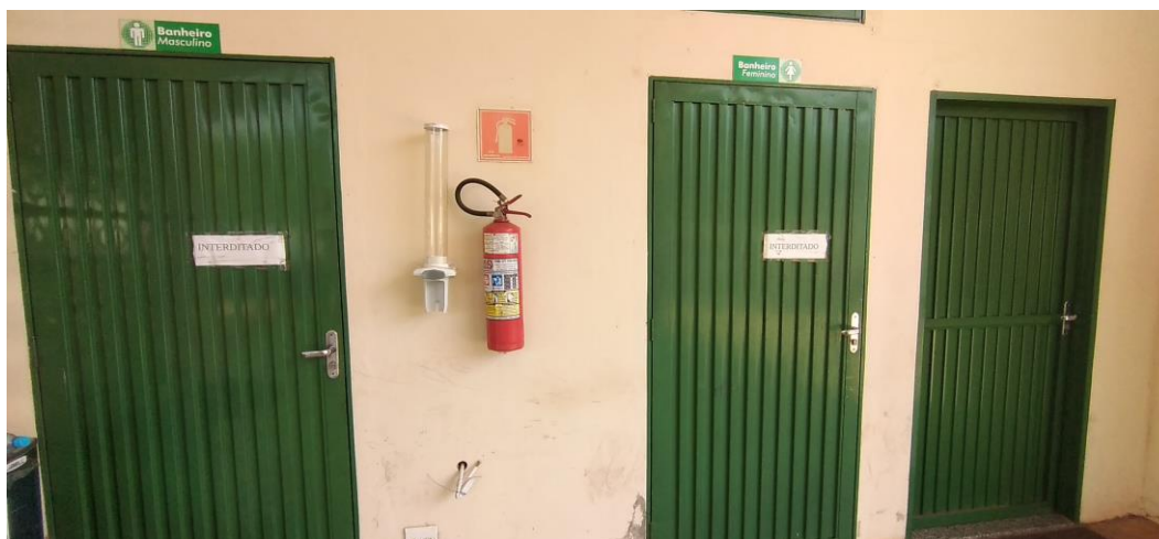
Foto 34: Portas Banheiros Externos e Porta de Acesso a Agência
