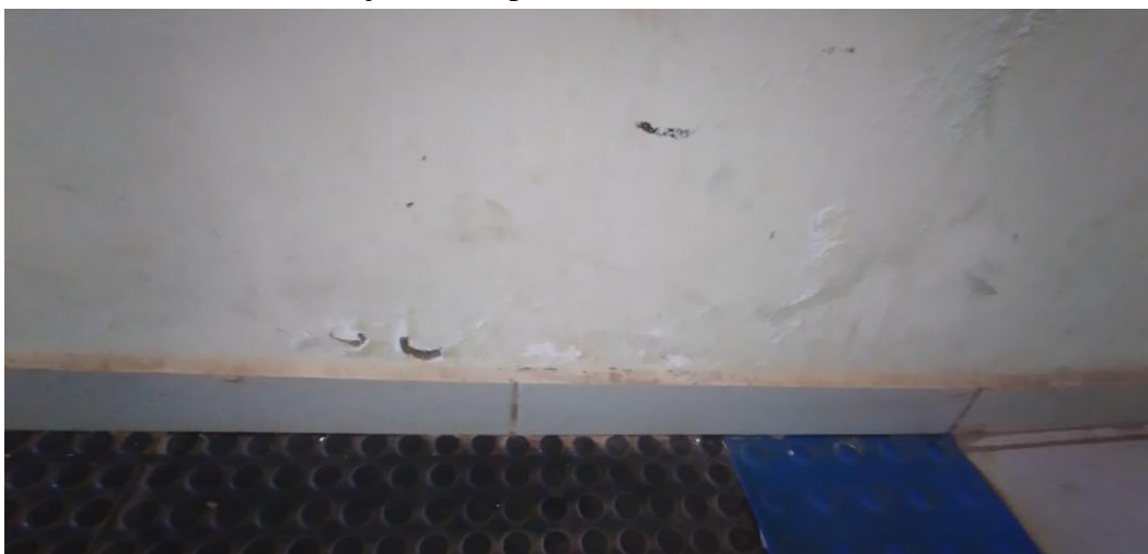
Foto 72: Parede da Rampa de Acessibilidade Danificada
