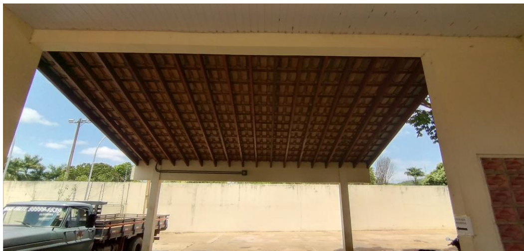
Foto 32: Telhado da Área de Vistoria
