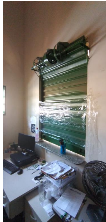
Foto 39: Janela de Atendimento da Vistoria
