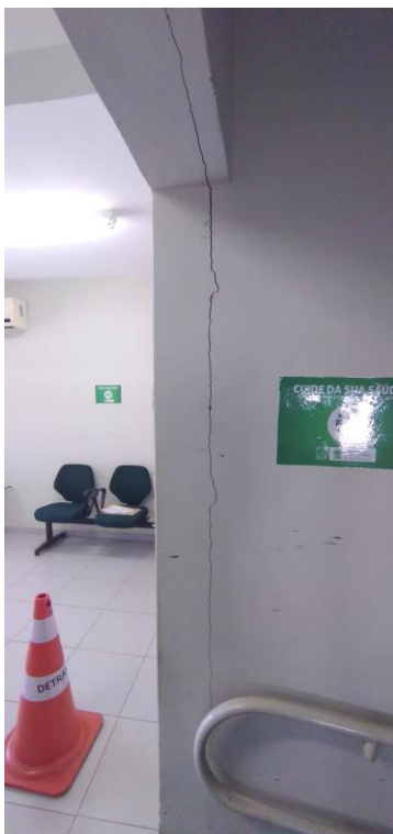
Foto 74: Parede da Área de Circulação Danificada
