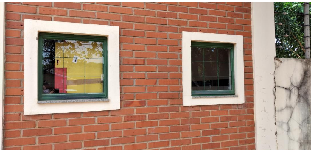
Foto 10: Janelas na Fachada Lateral
