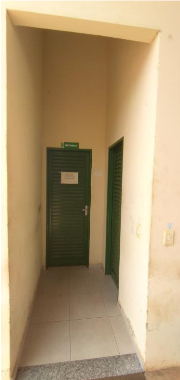
Foto 35: Área de Circulação
