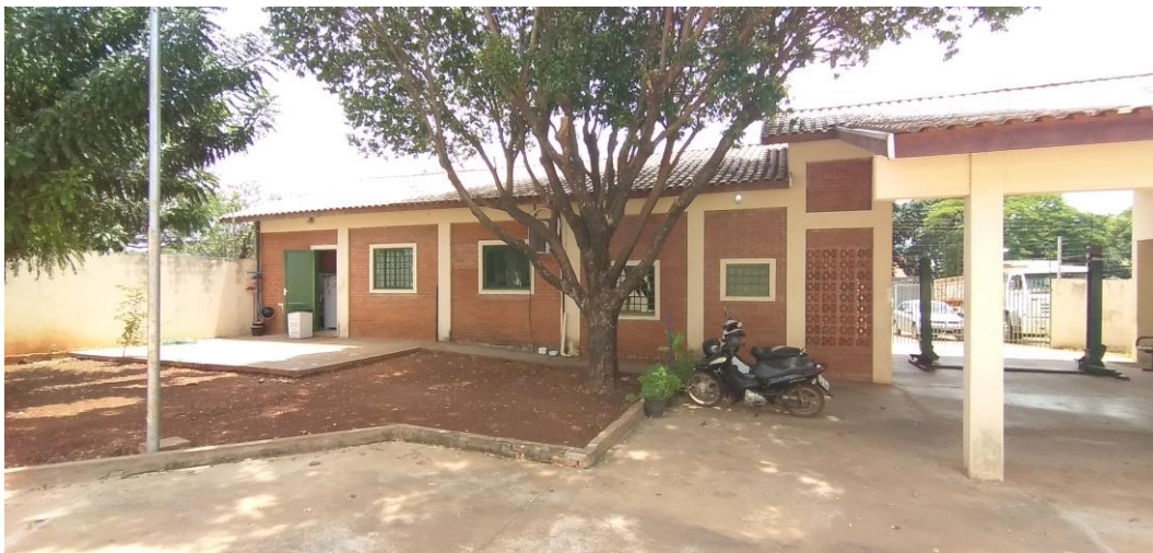
Foto 27: Fachada Lateral Interna
