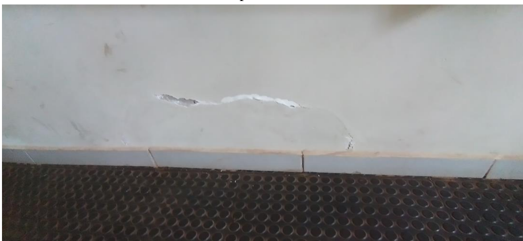
Foto 73: Parede da Rampa de Acessibilidade Danificada
