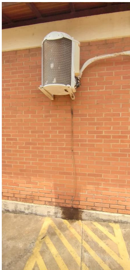
Foto 13: Dreno de Ar Condicionado
