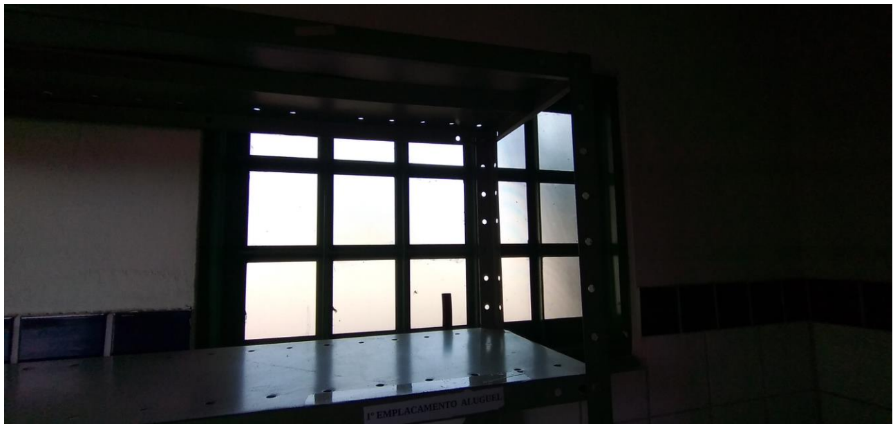
Foto 48: Janela Banheiro Masculino
