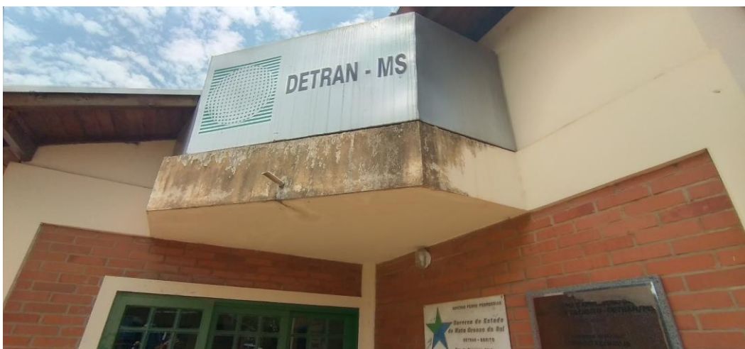
Foto 3: Marquise sobre Entrada Principal Danificada
