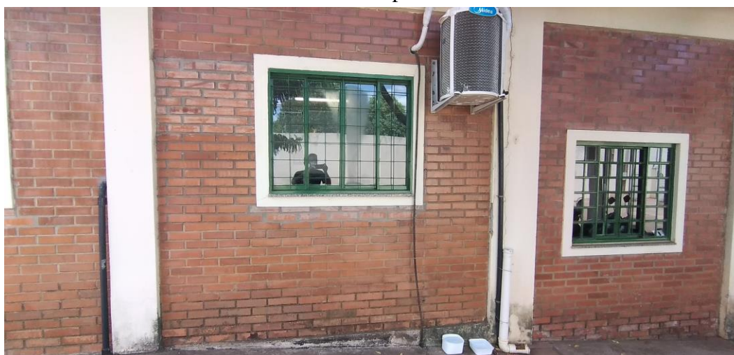
Foto 50: Janela da Rampa de Acessibilidade e da Sala de Digitação
