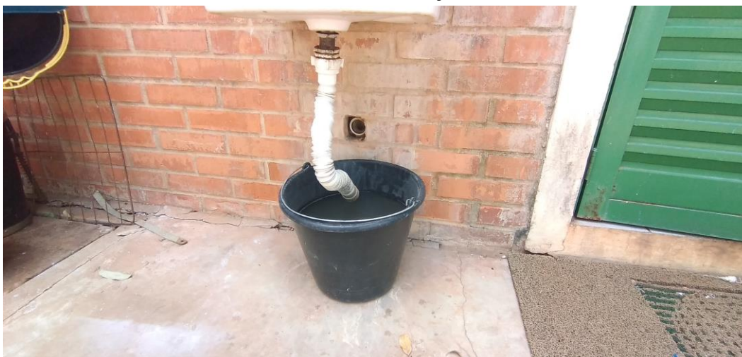
Foto 57: Sifão do Tanque da Área de Serviço
