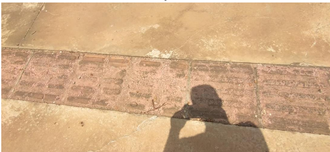
Foto 6: Piso Tátil Danificado
