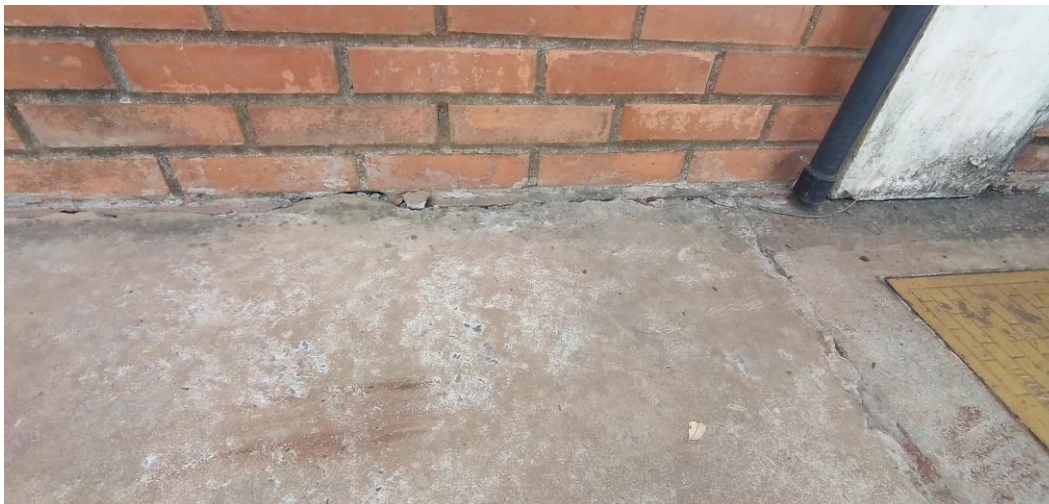
Foto 56: Encontro da Parede e da Calçada Externo Danificada
