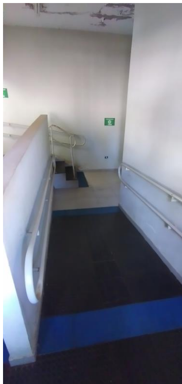
Foto 69: Rampa de Acessibilidade
