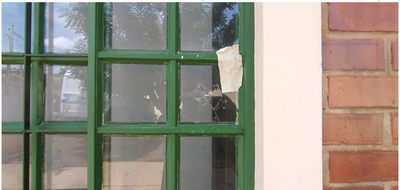
Foto 55: Janela da Área de Circulação Danificada
