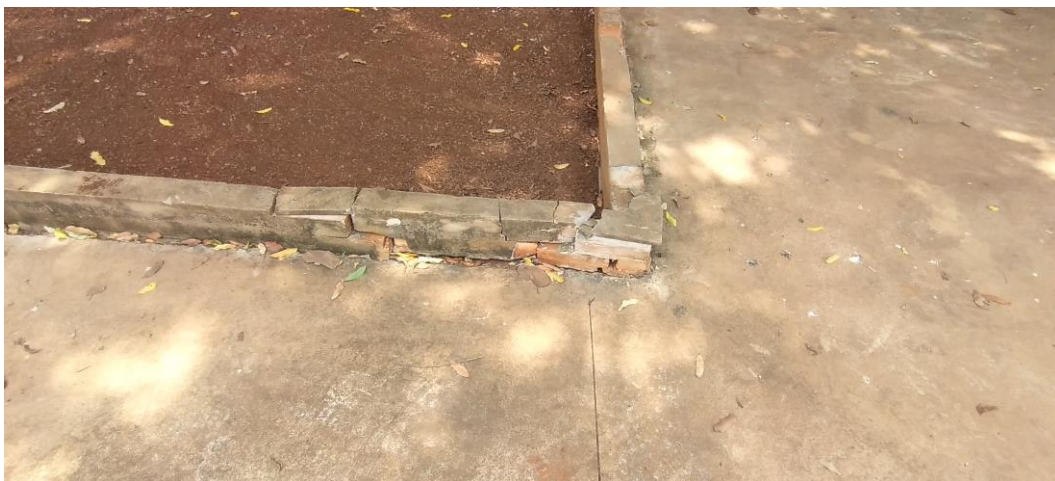
Foto 28: Calçada Interna Danificada
