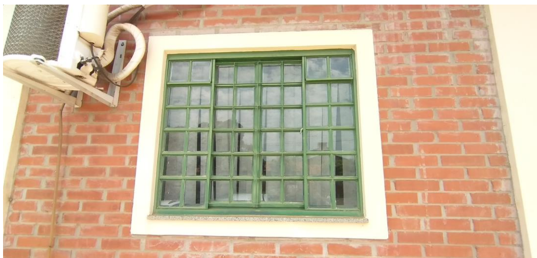
Foto 11: Janela na Fachada Lateral
