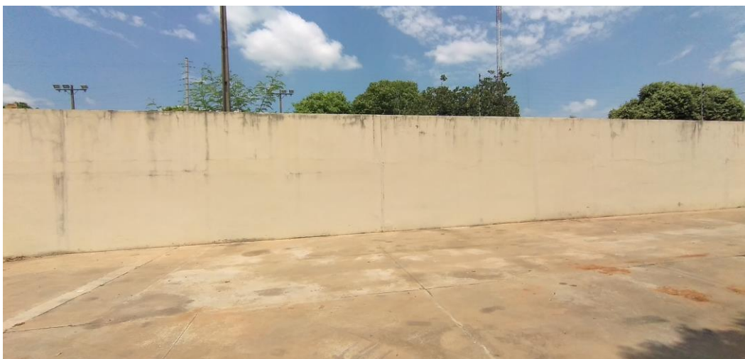
Foto 21: Muro Interno Danificado
