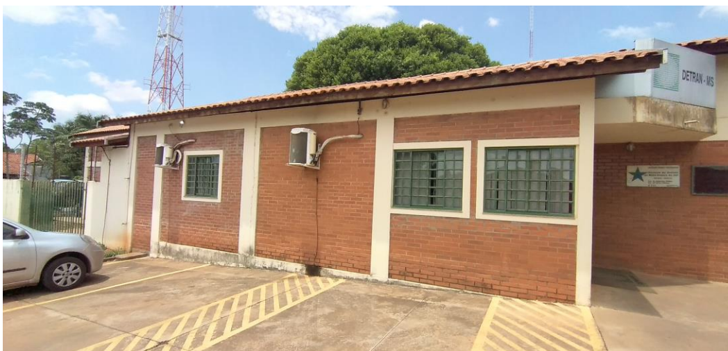
Foto 2: Fachada Lateral Externa
