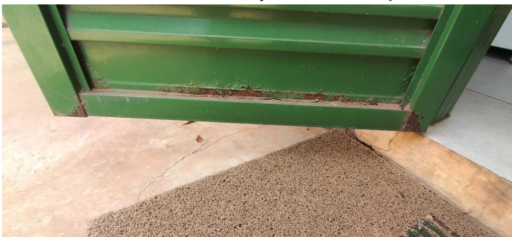
Foto 58: Porta de Acesso a Copa Danificada
