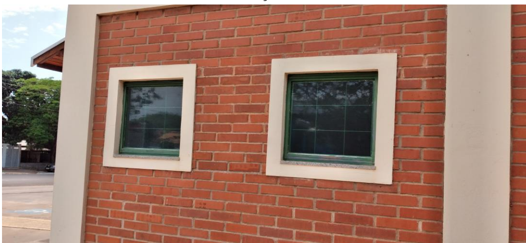
Foto 9: Janelas na Fachada Lateral
