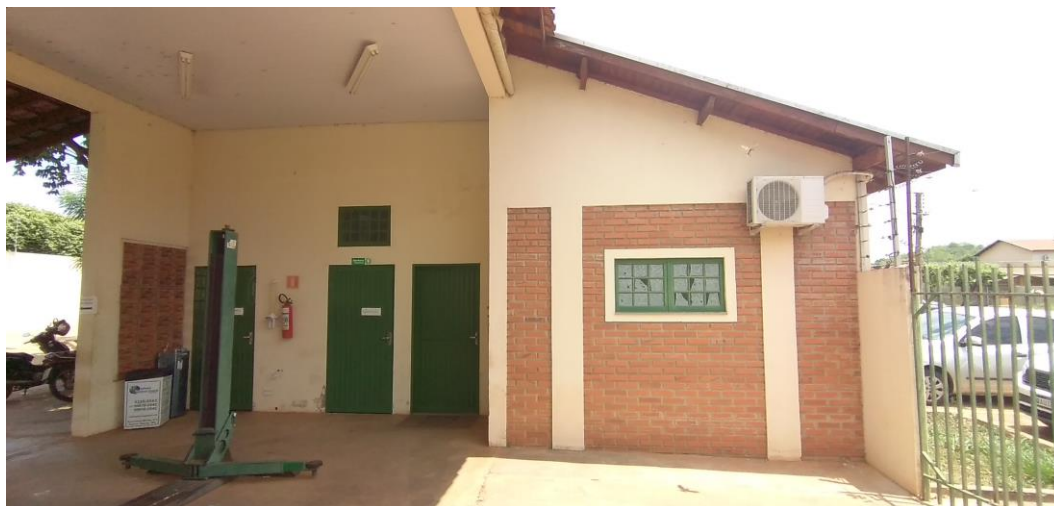
Foto 105: Área de Vistoria e Fachada Posterior
