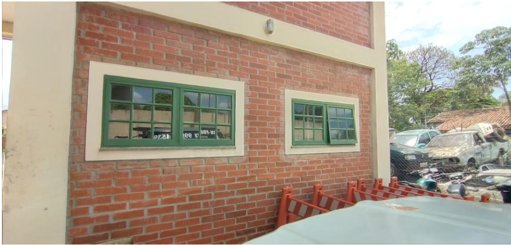
Foto 29: Janelas da Sala de Vistoria e do Depósito
