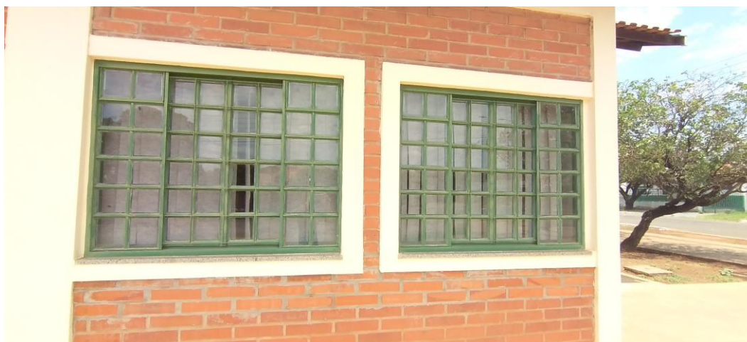
Foto 12: Janelas na Fachada Lateral
