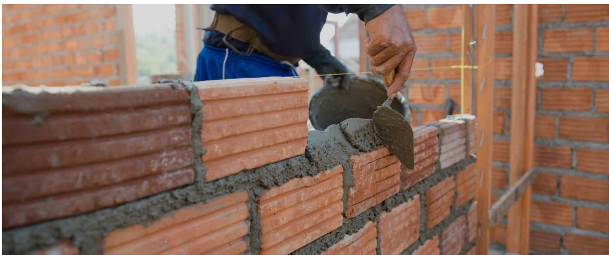
Foto 4 - Ilustração de assentamento de blocos cerâmicos com largura de 14 cm.
