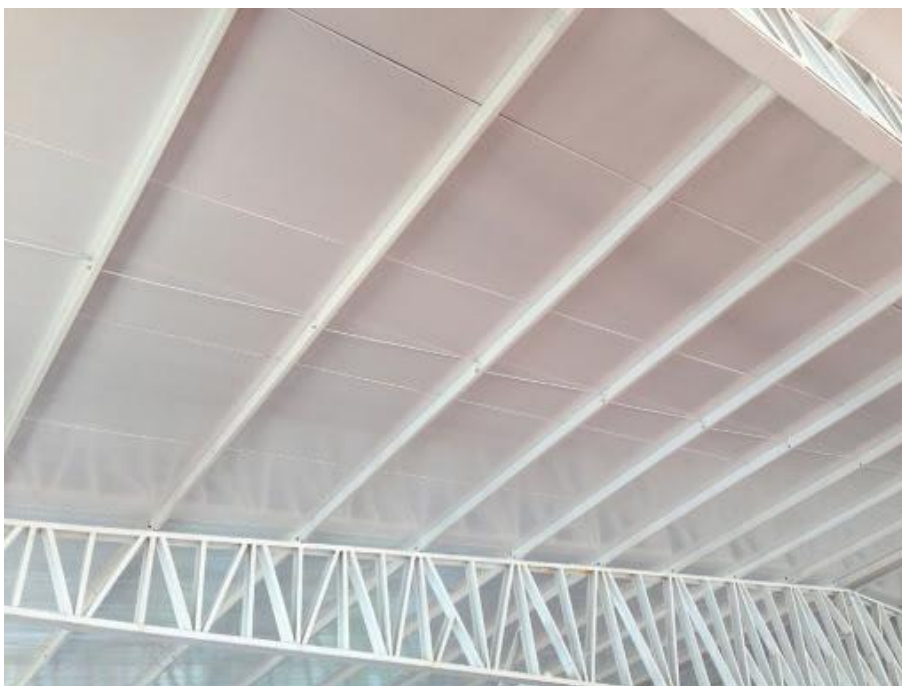
Exemplo de acabamento das telhas do tipo telha-forro.
