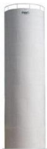
Foto - Reservatório cilíndrico.
