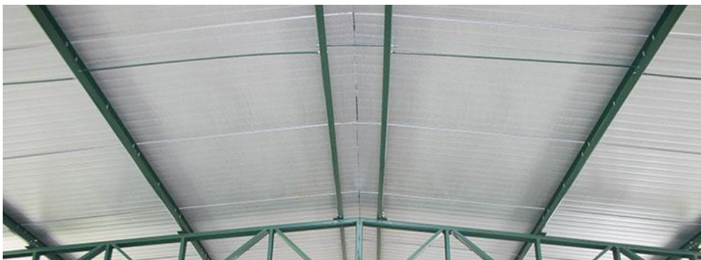
Exemplo de acabamento das telhas do tipo telha-forro.
