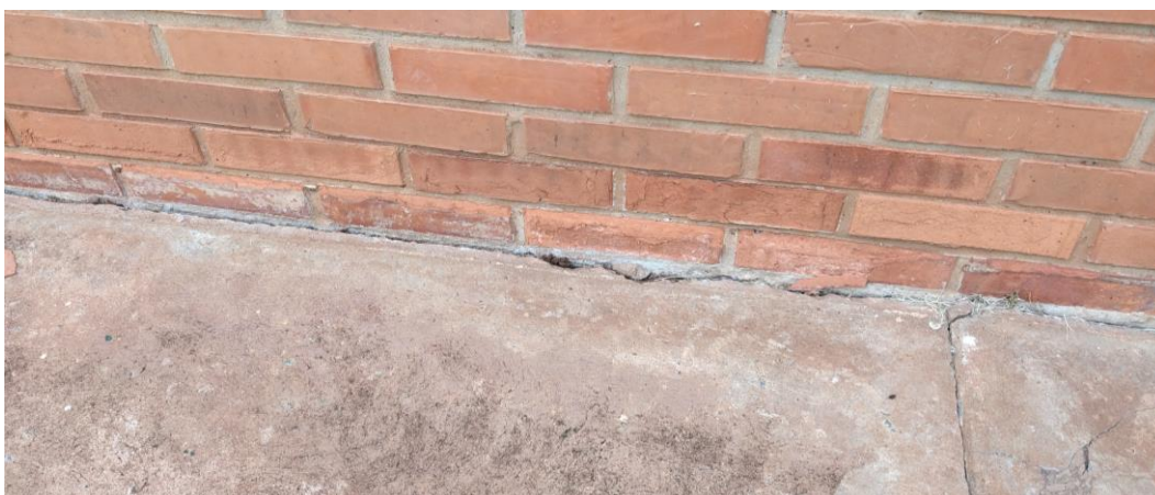
Foto 21: Fissura no encontro do piso com a parede
