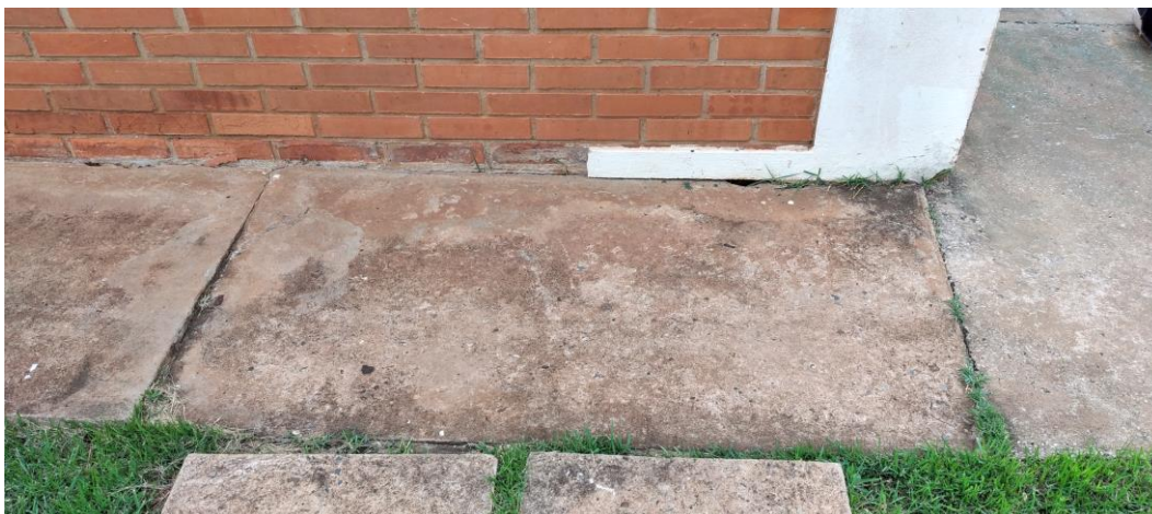
Foto 18: Fissura no encontro do piso com a parede
