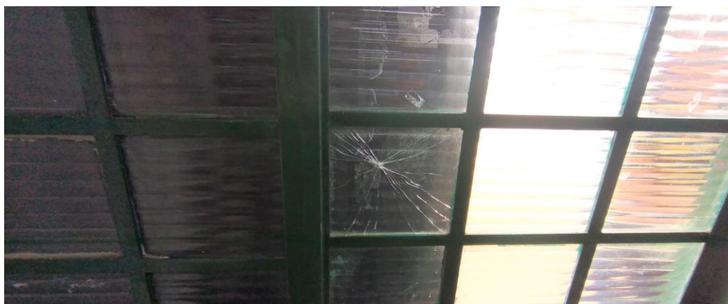
Foto 31: Janela área de atendimento danificada
