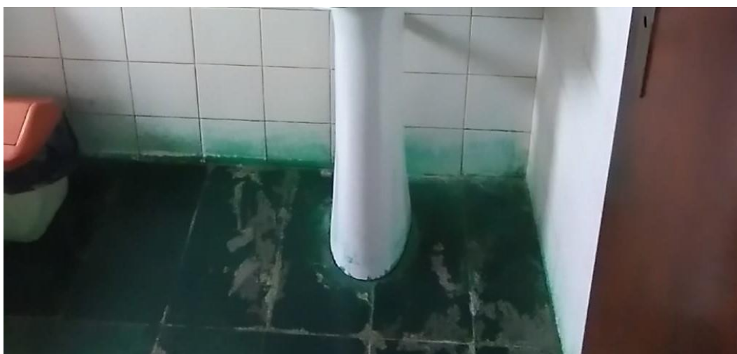
Foto 54: Revestimento danificado no banheiro masculino
