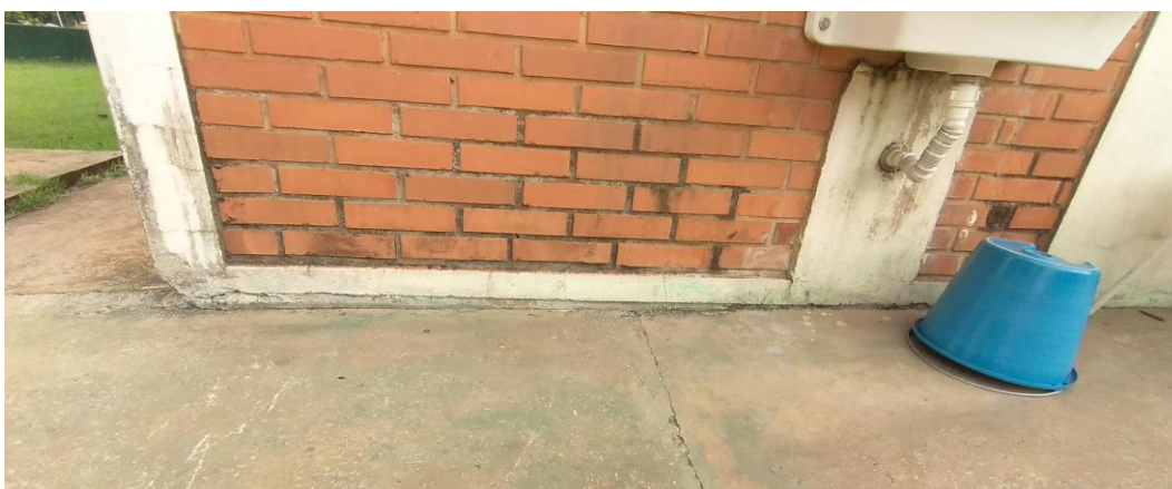
Foto 17: Fissura no encontro do piso com a parede
