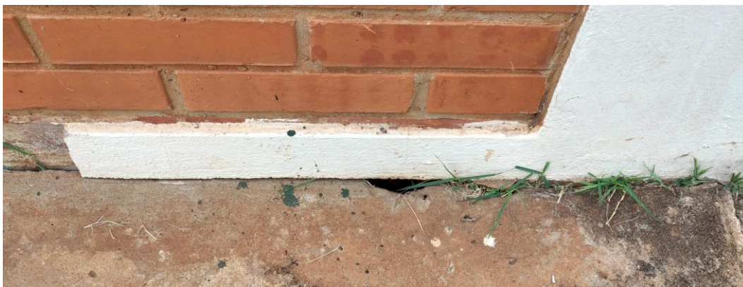
Foto 19: Fissura no encontro do piso com a parede
