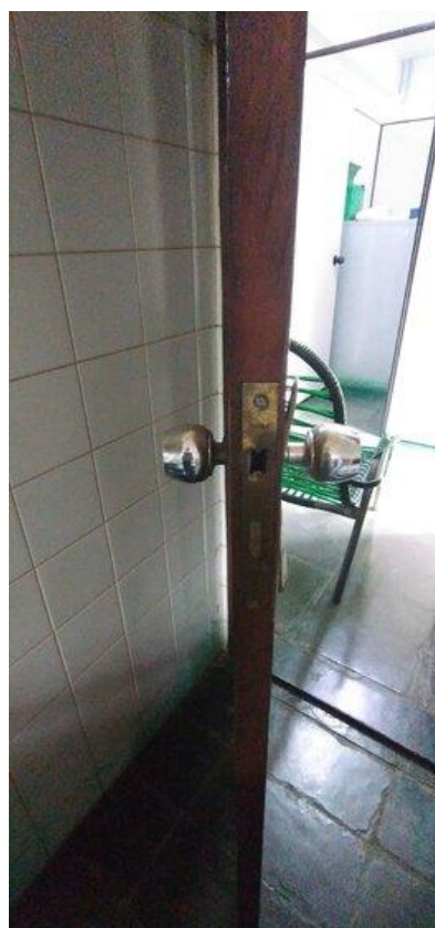
Foto 63: Trinco danificado
