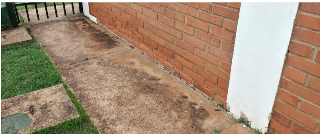
Foto 20: Fissura no encontro do piso com a parede
